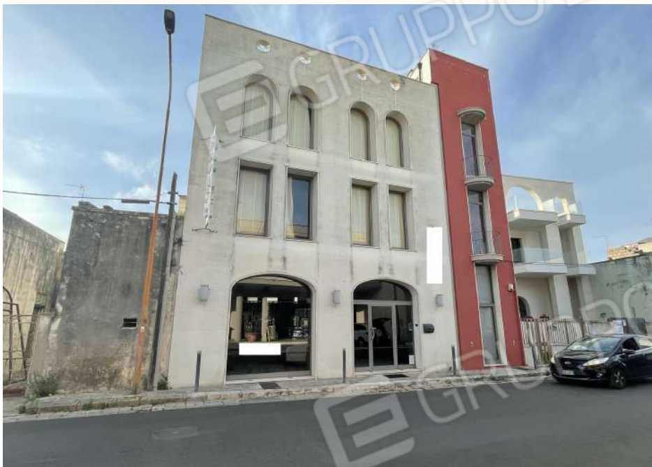
Vista del locale commerciale da via Roma
