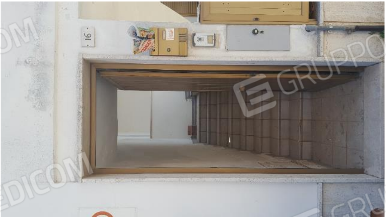
04 - Civico 16 su via Verdi: portone d'ingresso al vano scala di esclusiva pertinenza.
