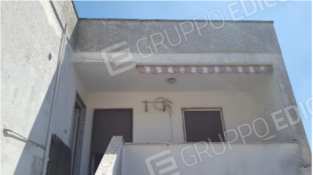
05 - Balcone sul fronte principale. Sulla sinistra i due accessi all'abitazione.
