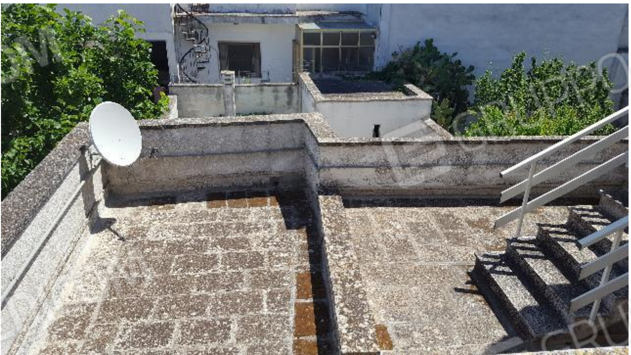
20 - Terrazzo sul retro, vista verso nord-est.
