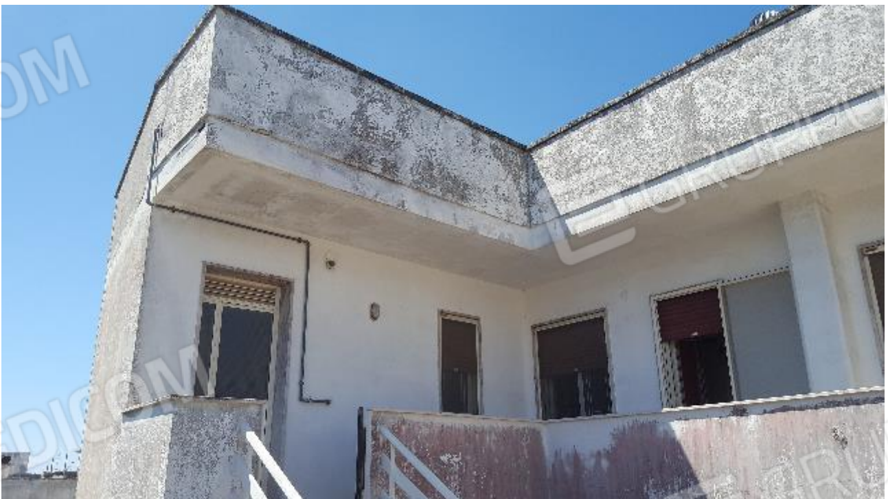
18 - Altra vista dei balconi sul retro. Sulla sinistra il varco al locale tecnico - lavanderia.
