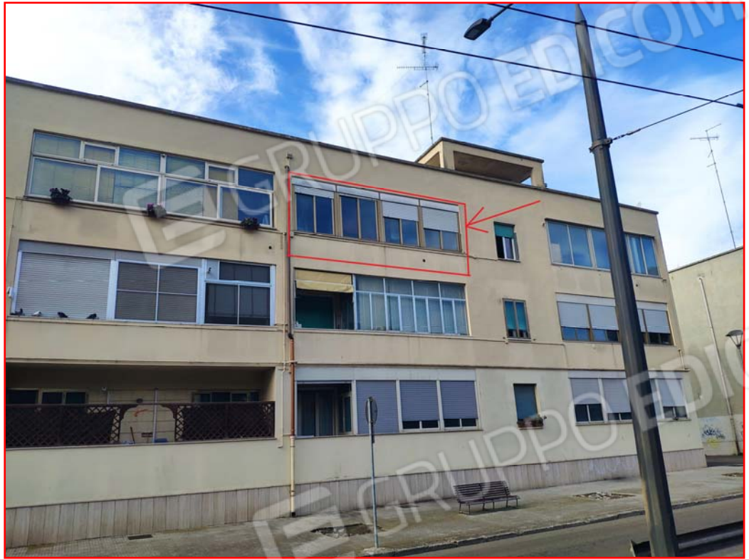
Foto 1 - Vista dell'immobile esecutato da Viale Japigia
