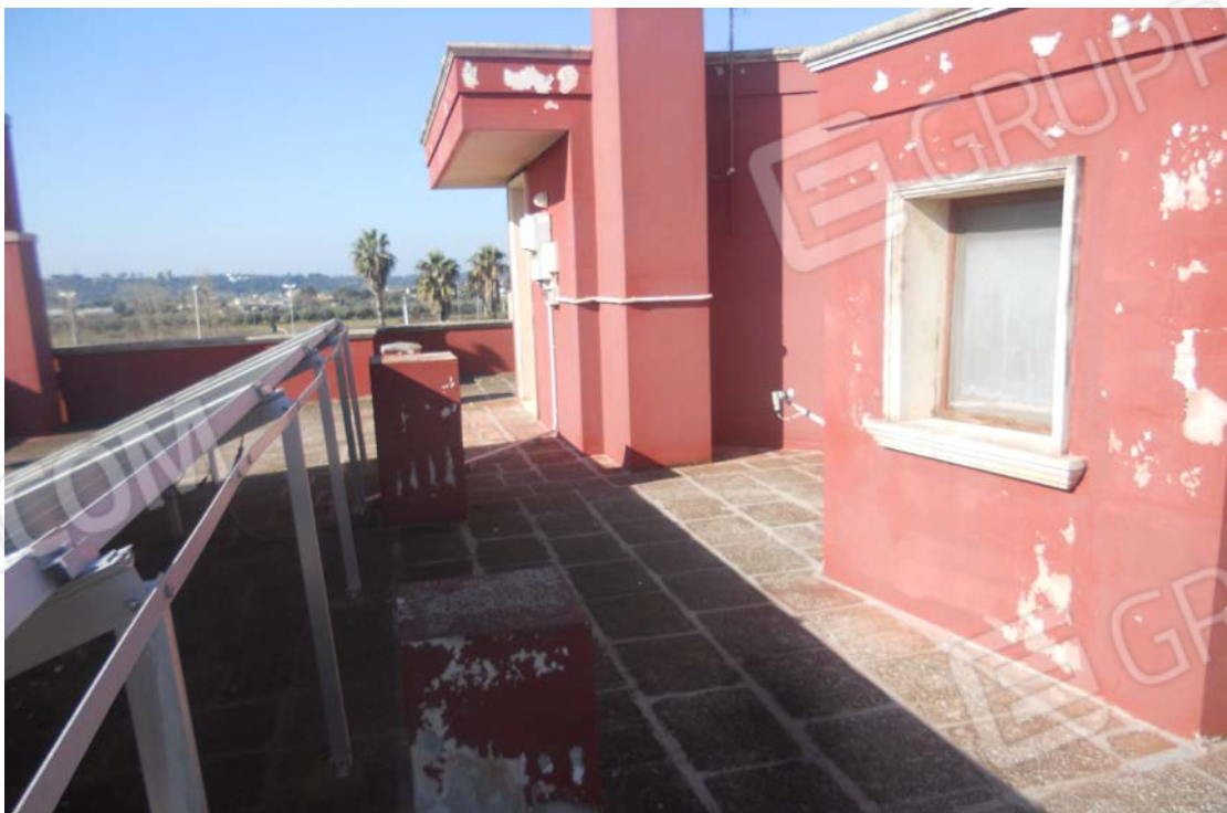
FOTO N.8 PARTICOLARE LASTRICO SOLARE
