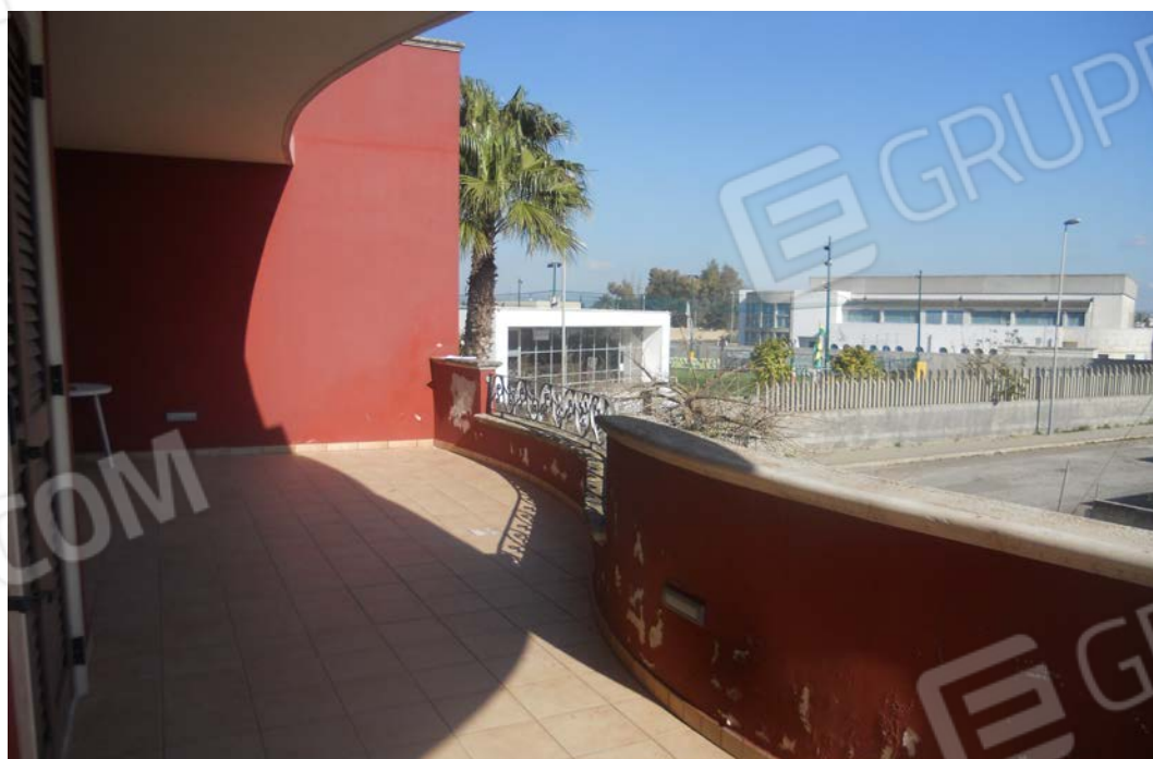
FOTO N6. PARTICOLARE VERANDA PRIMO PIANO
