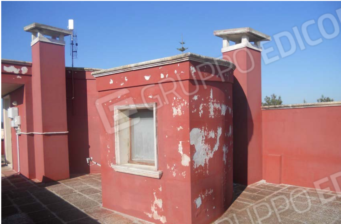
FOTO N.7 PARTICOLARE TORRETTA VANO SCALA
