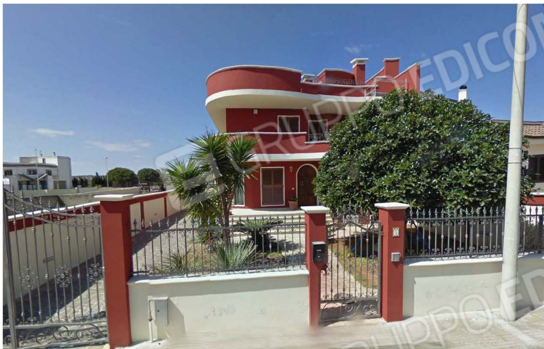
FOTO N.1 PROSPETTO SU VIA FRATELLI ROSSELLI
