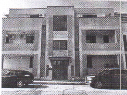
Vista del condominio
