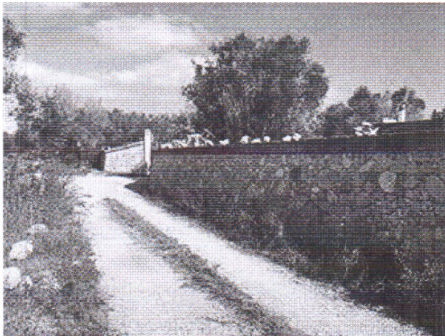
Recinzione lungo la strada di accesso
