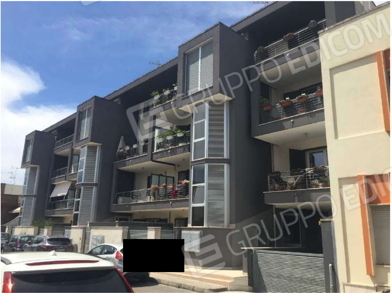
FOTO N. 1 Prospetto principale su accesso da via Sele
