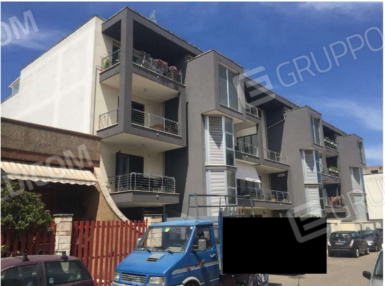
FOTO N. 2 Prospetto principale su via Sele
