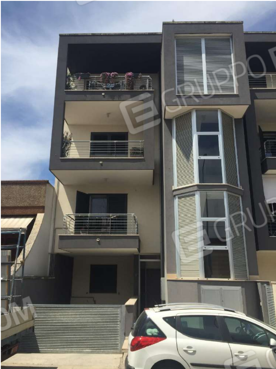
FOTO N. 4 Accesso al P.S1 da rampa lato scala A su via Sele
