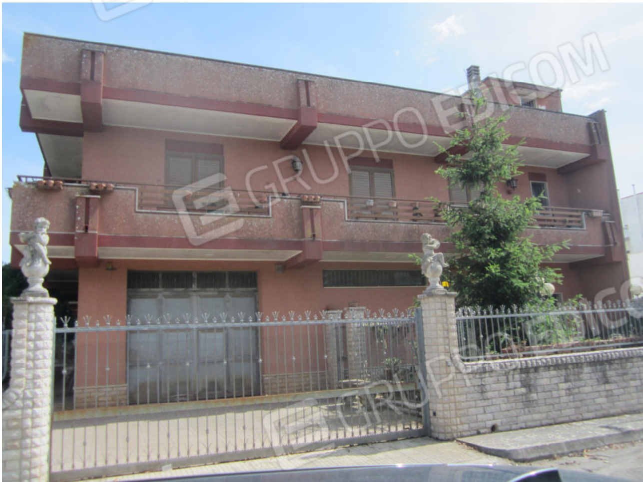
Foto n. 01 – fronte immobile sulla Via Bologna
