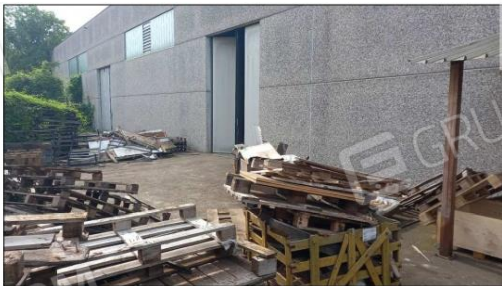
Lotto 1 – Foto n. 24 – Piazzale esterno posteriore
