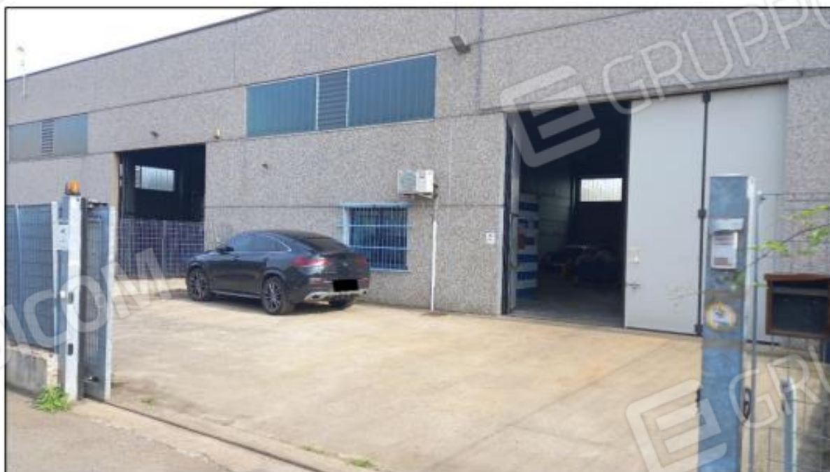
Lotto 1 – Foto n. 2 – Prospetto sud con ingresso principale da traversa di Corso Genova (SS 35 dei Giovi) e piazzale esterno anteriore
