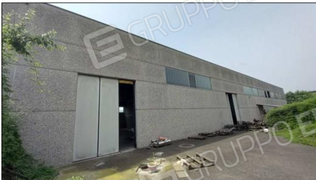
Lotto 2 – Foto n. 39 – Prospetto posteriore con piazzale esterno
