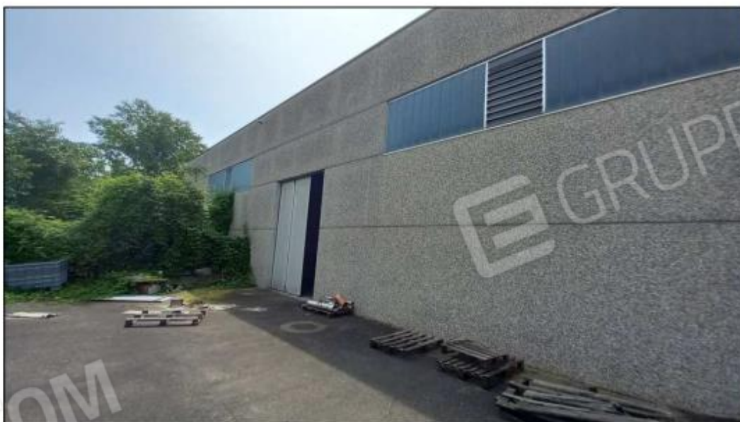
Lotto 2 – Foto n. 40 – Prospetto posteriore con piazzale esterno
