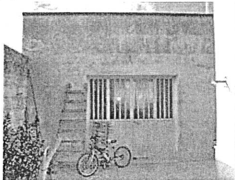
Prospetto interno sul SUB 4 B.C.N.C.
