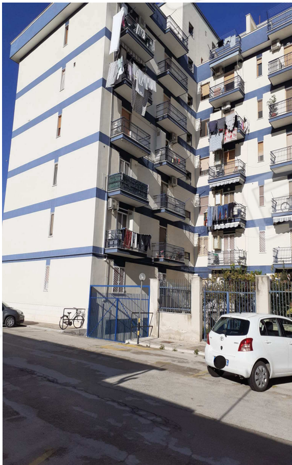
ACCESSO BOX (CORTILE INTERNO)
