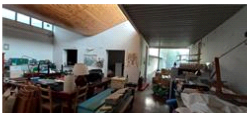
Vista interna e intradosso copertura in listelli in legno industriale
