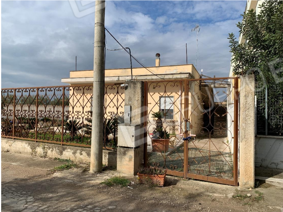
Foto 2. Vista fabbricato ingresso pedonale Via Lagnone Santa Croce, n°281
