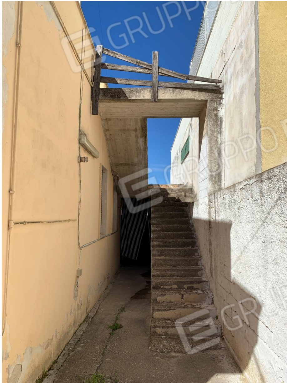
Foto 6. Dettaglio scala d'accesso lastrico solare lato Nord
