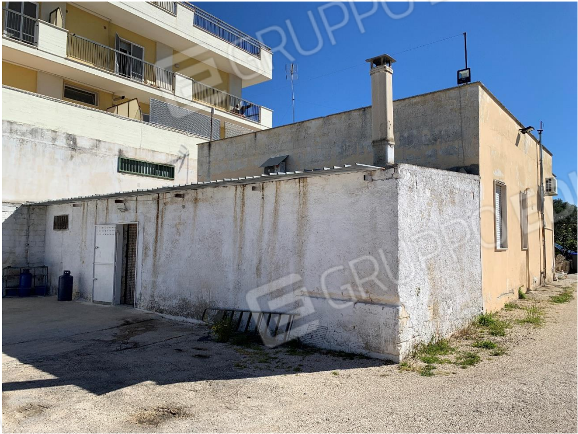
Foto 5. Vista fabbricato lato Ovest
