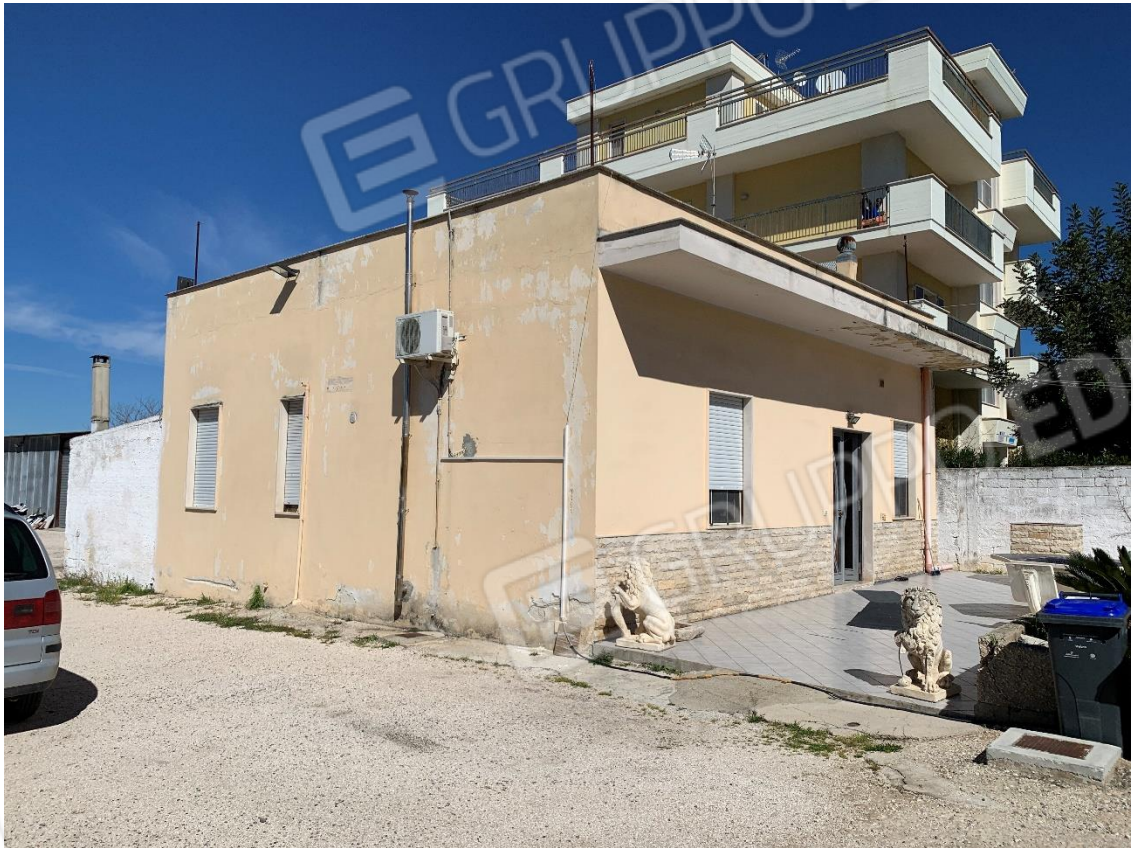
Foto 4. Vista fabbricato lato Sud - Est
