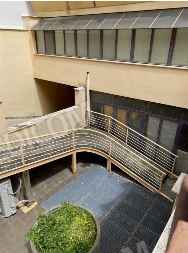
Foto 4.2 – Area esterna scoperta
