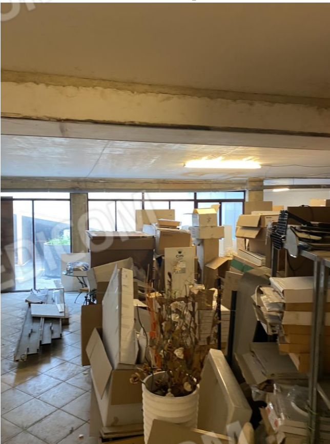
Foto 4.6 – Interno della zona deposito
