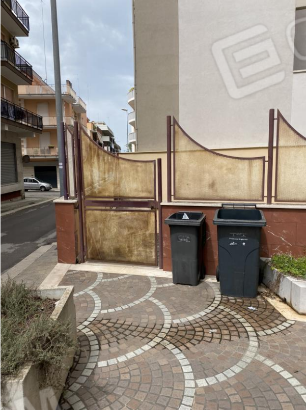
Foto 4.1 – Ingresso esterno a piano terra
