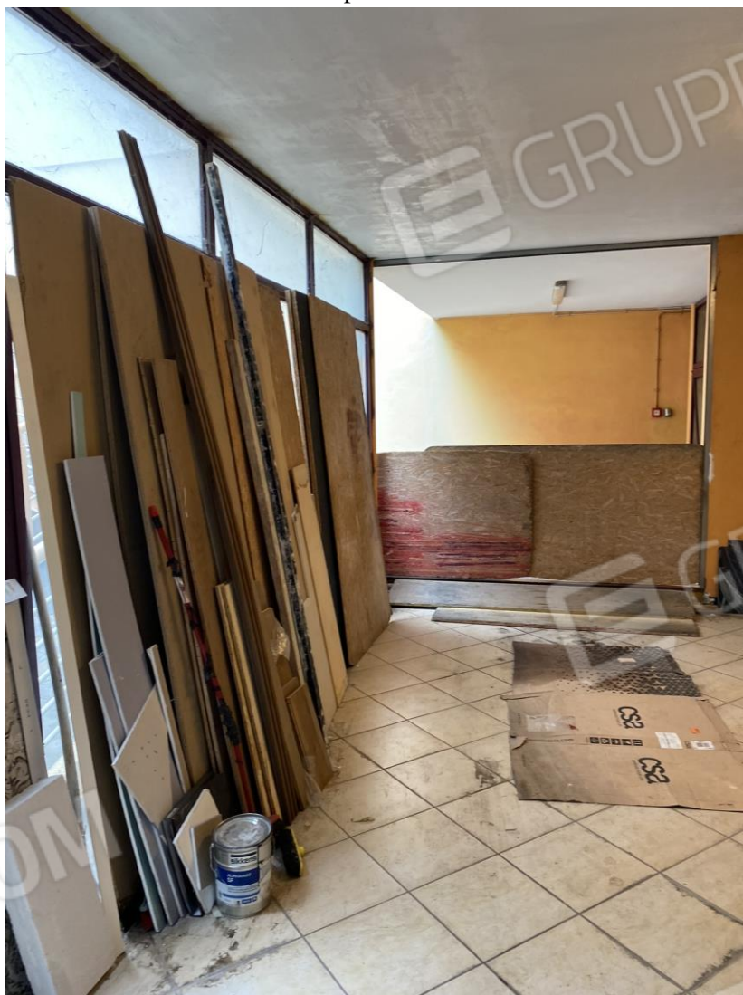
Foto 4.7 – Interno della zona deposito
