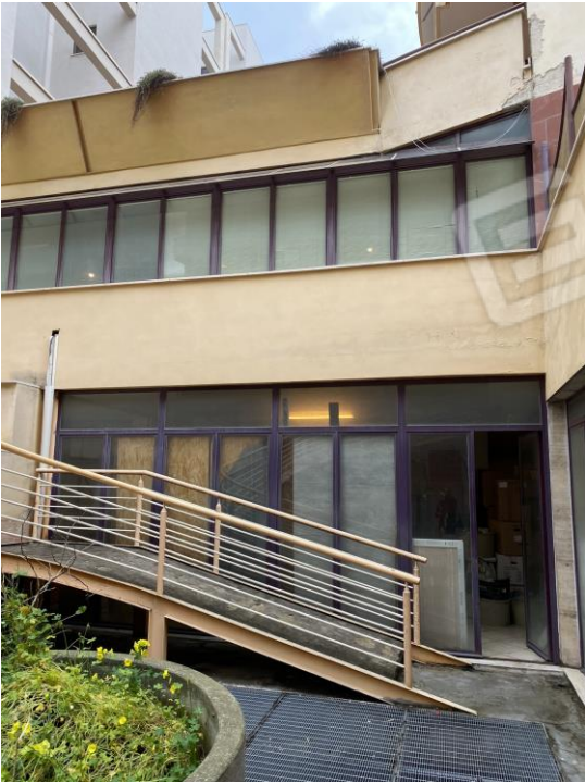
Foto 4.3 – Area esterna scoperta
