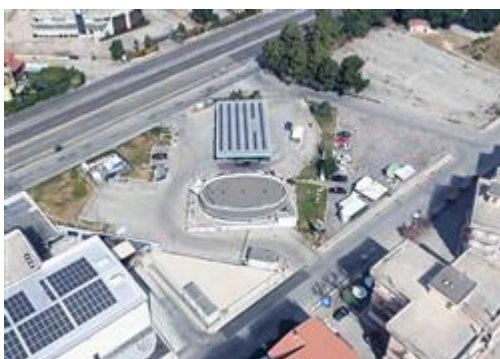
Vista aerea della stazione di servizio.
