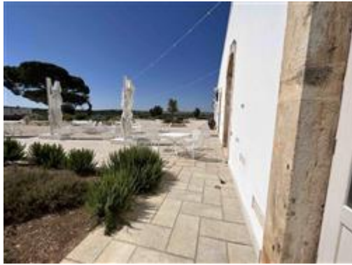
Stato di fatto marciapiedi prospetto a est
