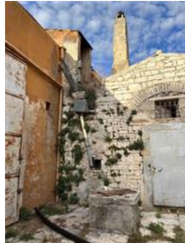
Prospetto retrostante con accesso al sottotetto
