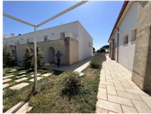
Stato di fatto marciapiedi prospetto a sud
