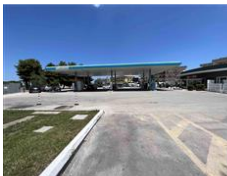
Pensilina a protezione delle pompe di distribuzione carburanti.
