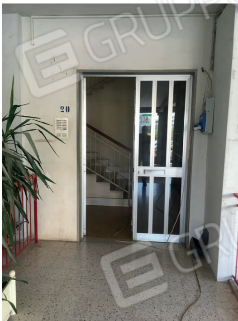
Foto 1 - Portone d'accesso all'androne e vano scale condominiali
