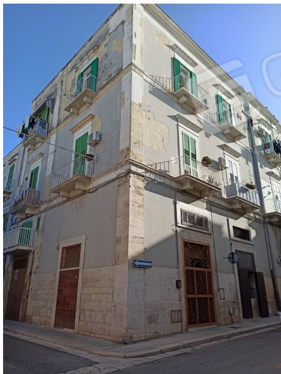
Vista del fabbricato tra la via Roma e la via G. Bruno
