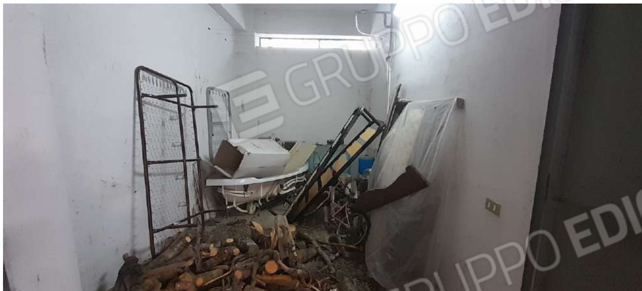
Foto 20 Vista interna Corridoio di Scorrimento
