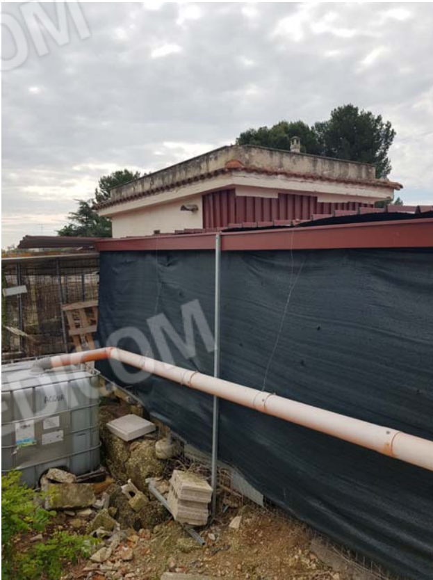
macerie della villa crollata
