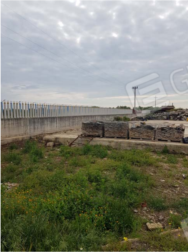
piattaforma in cemento
