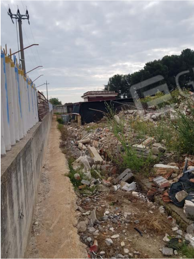
macerie della villa crollata
