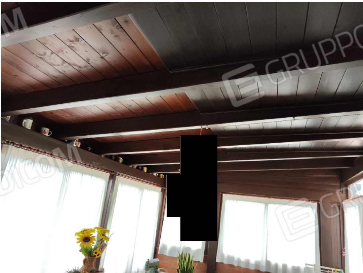
foto 13 veranda con gli infissi da rimuovere sub 20
