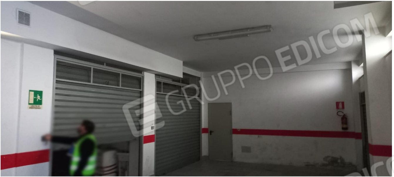
SERRANDA DI ACCESSO AL BOX N17
