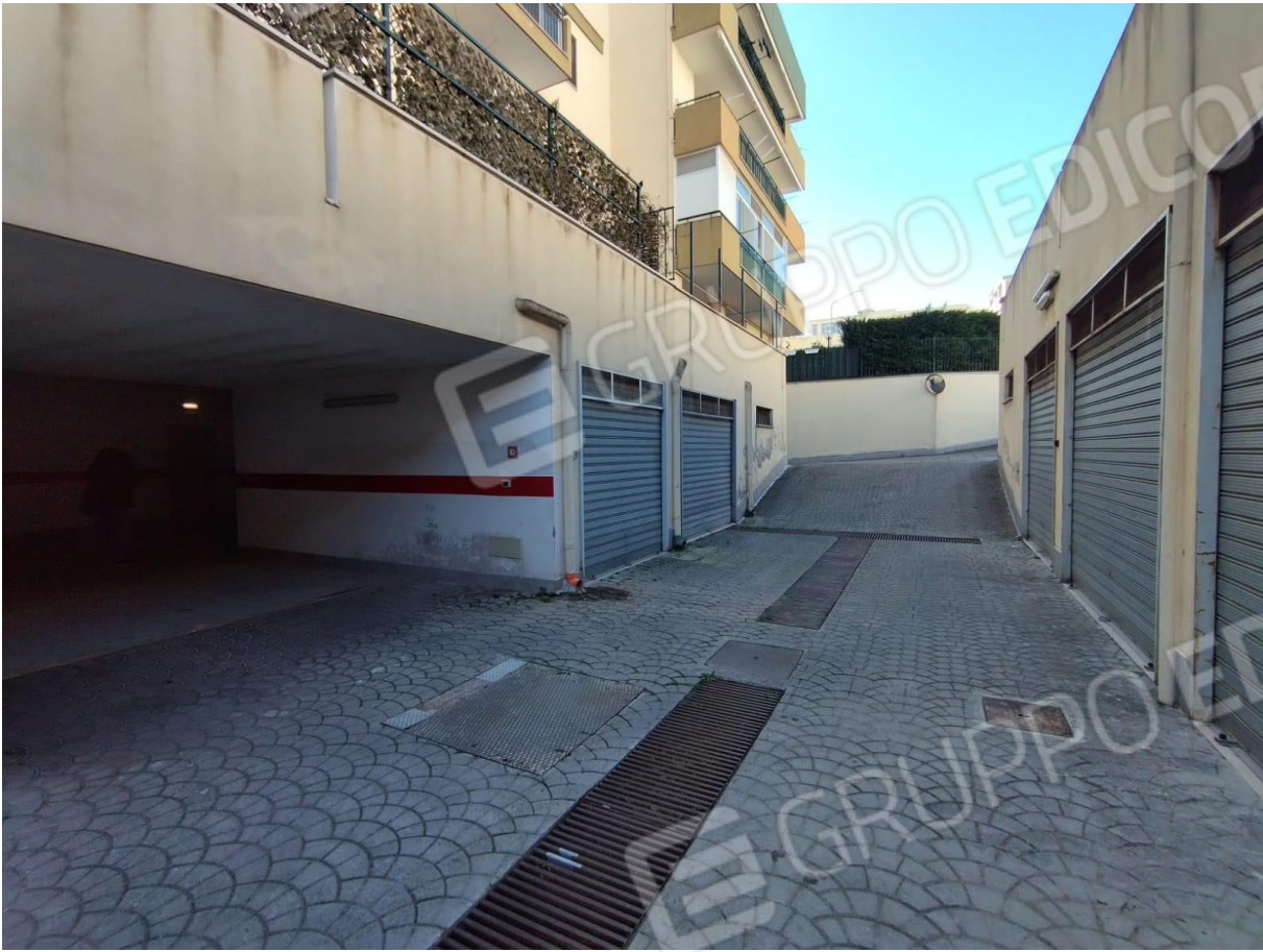
RAMPA ACCESSO AL PIANO SEMINTERRATO
