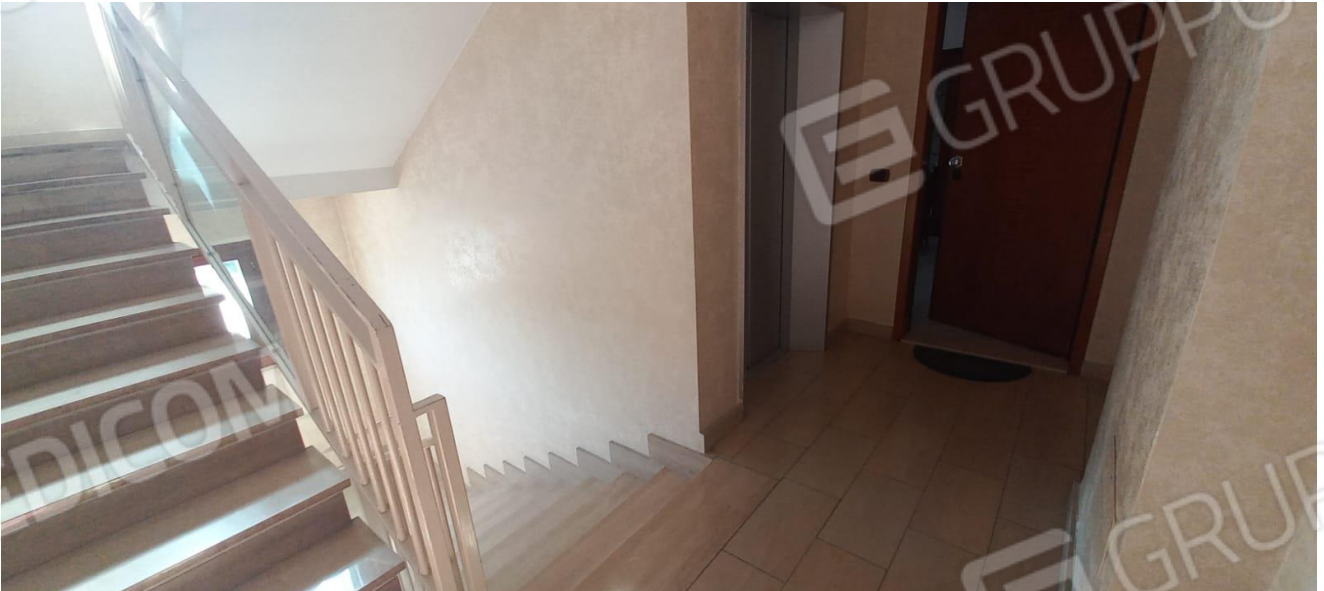
VANO SCALE ACCESSO APPARTAMENTO
