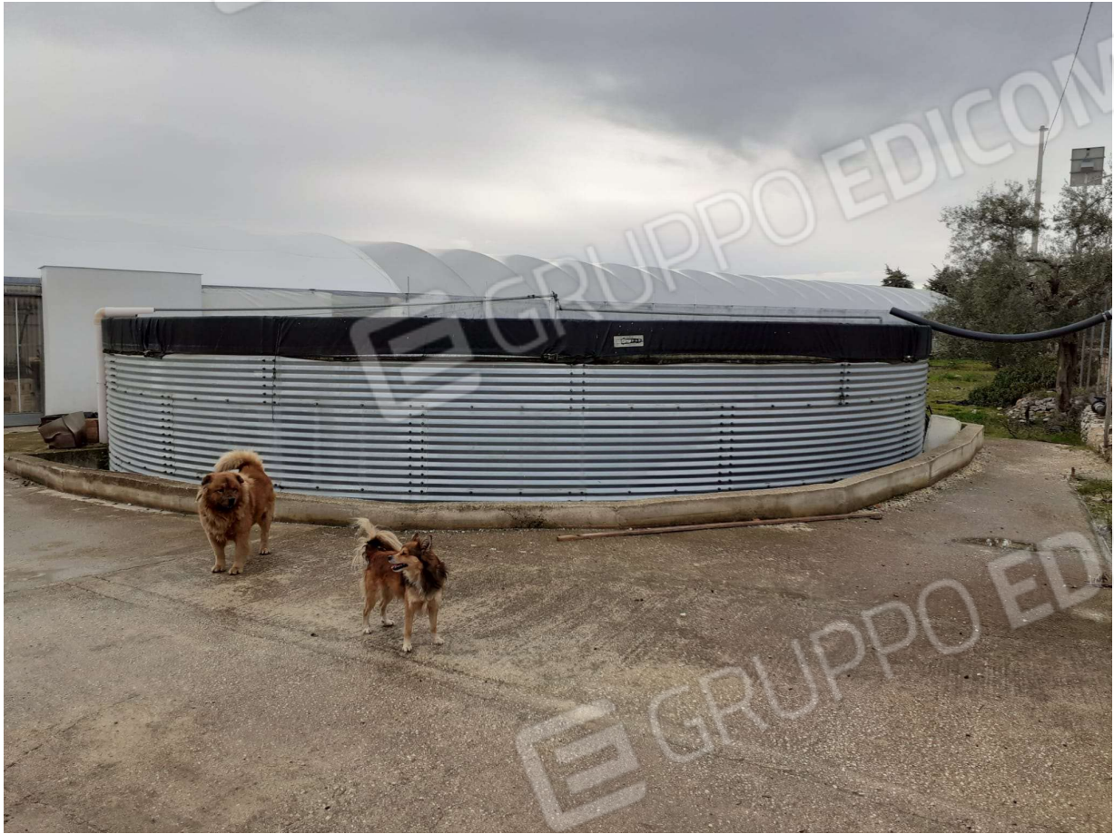
VASCA IN ACCIAIO PER ACCUMULO ACQUA
