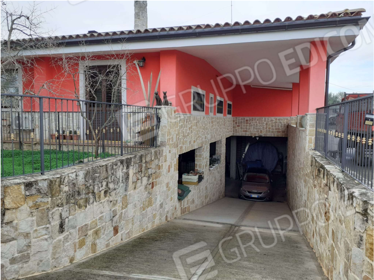
INGRESSO PIANO INTERRATO (LATO NORD)
