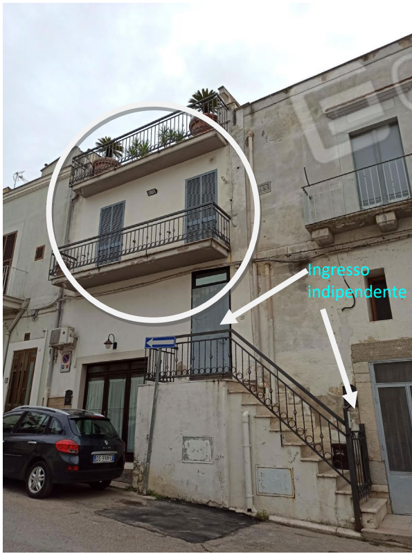
Foto 01 - Vista dell'ingresso dal C/so Traiano
