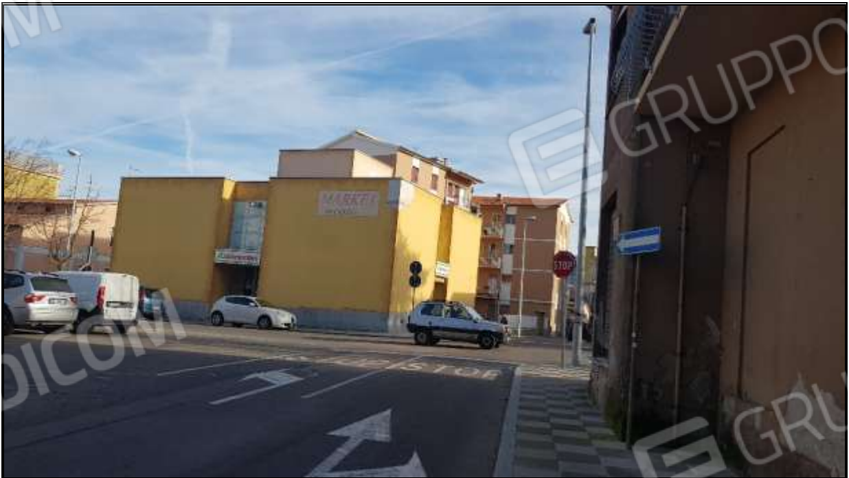
Foto 1 – prospetto lato Nord
