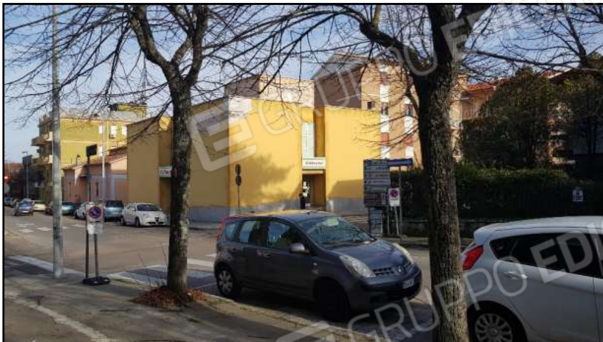
Foto 2 – prospetto lato Ovest
