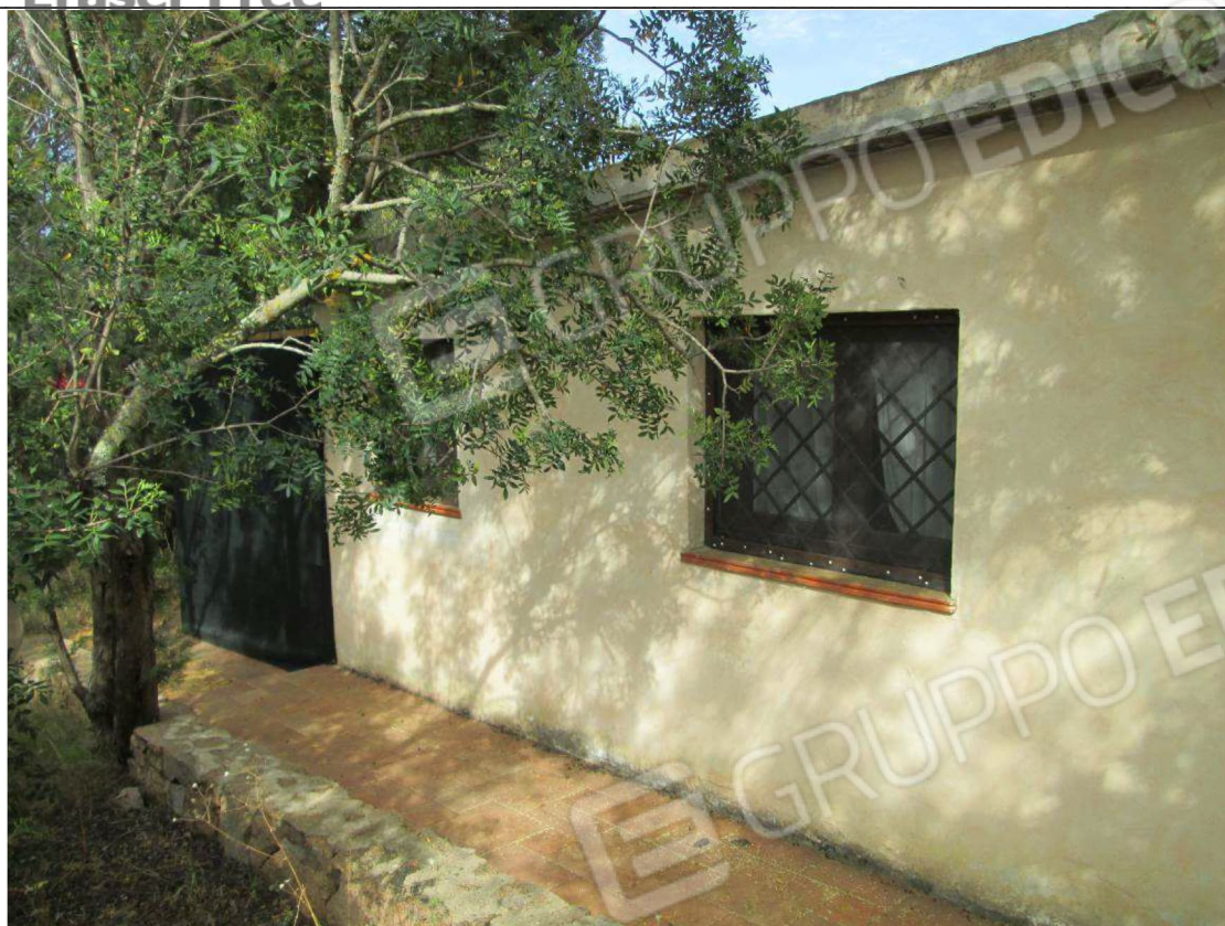
15 – Vista sulla dependance da demolire –
