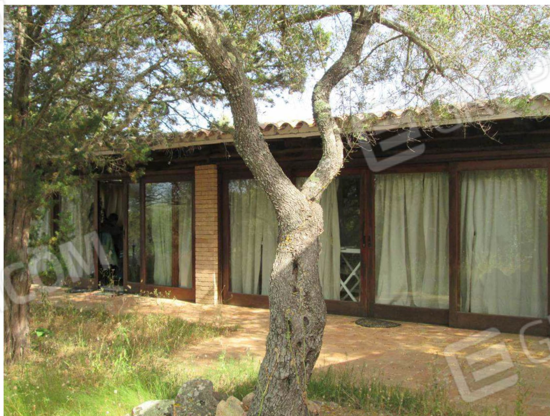
Foto n° 2 – Veranda chiusa lato Nord – parte non condonabile
