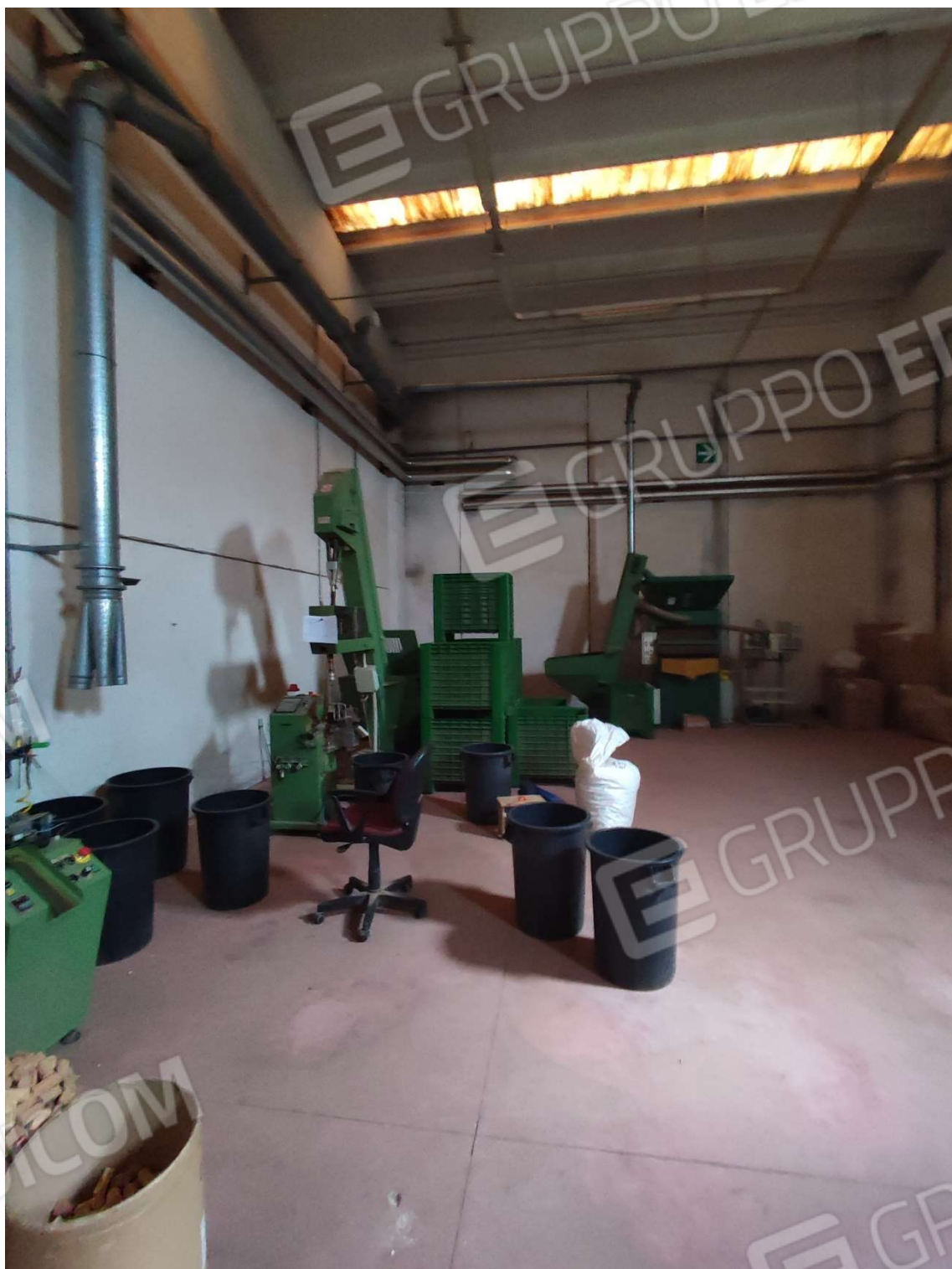
FOTO 032 – PIANO TERRA, SALA LAVORAZIONE 2
