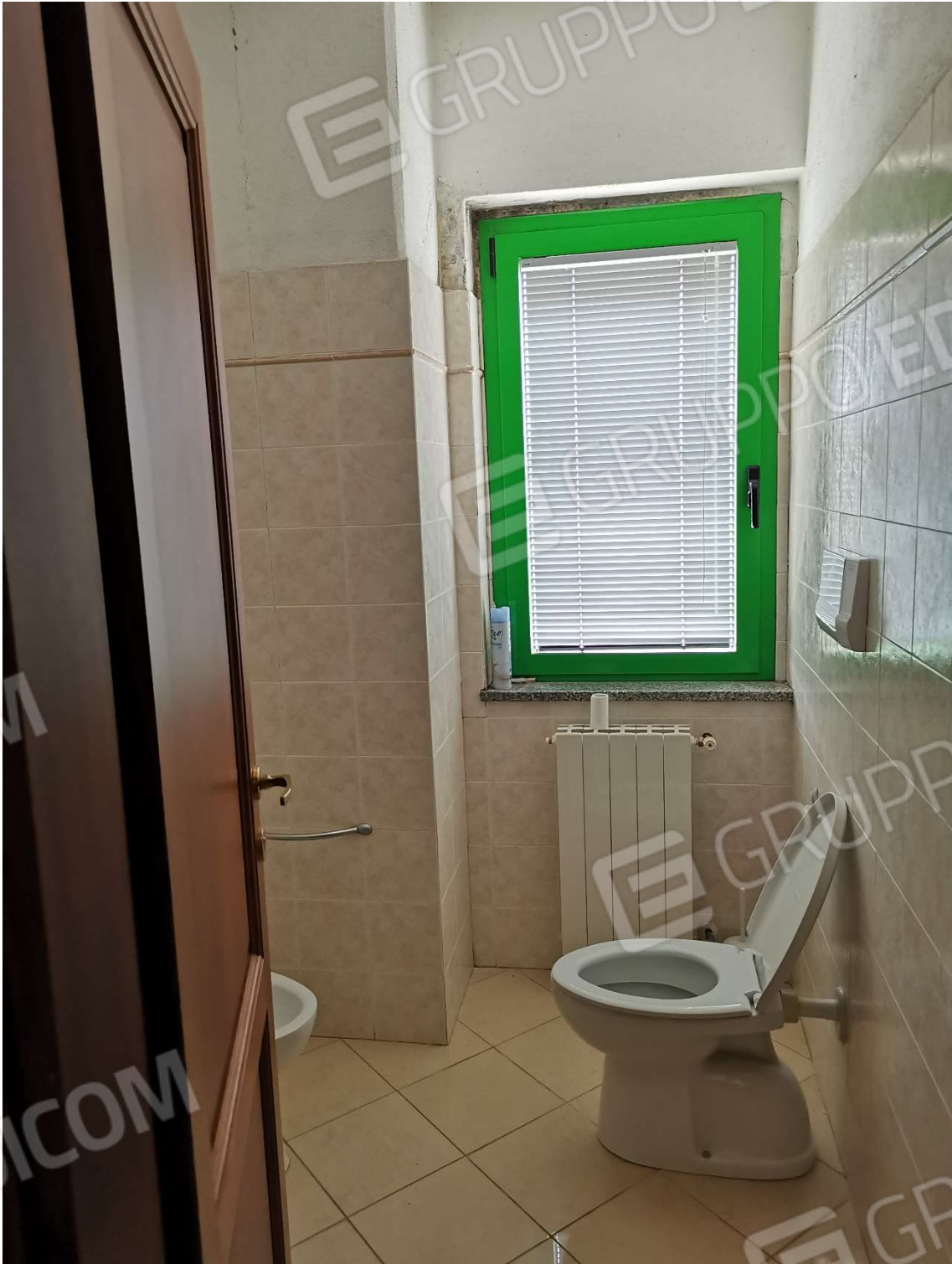
FOTO 042 – PIANO PRIMO, BAGNO
