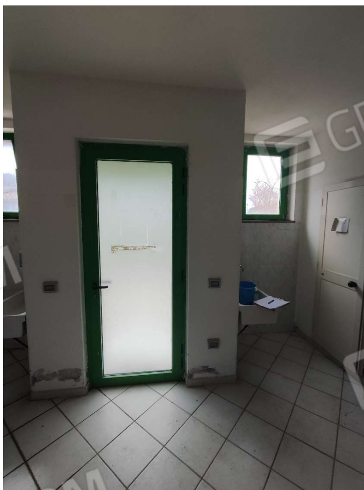
FOTO 017 – PIANO TERRA, SPOGLIATOIO UOMINI
