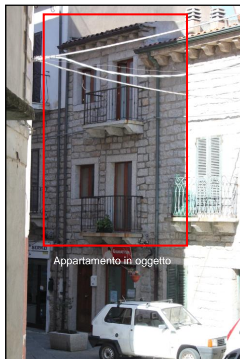
Fig. 2: Prospetto principale fabbricato
