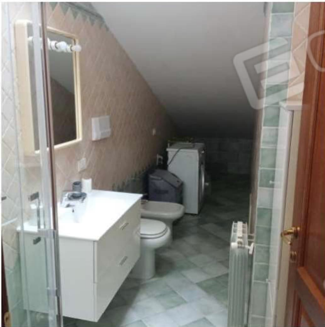
Foto 07 - Vano impropriamente adibito a bagno
