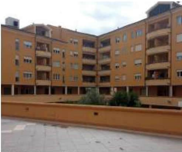
Foto 01 - Corpo di fabbrica B.
