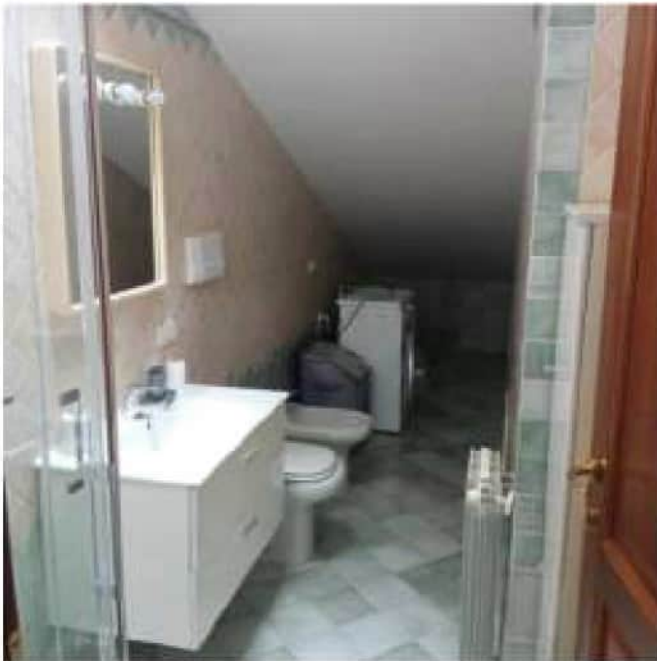
Foto 07 - Vano impropriamente adibito a bagno
