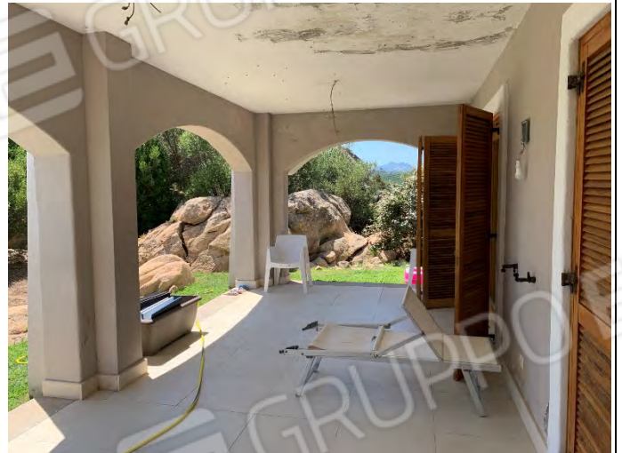
FOTO VERANDA PIANO TERRA
