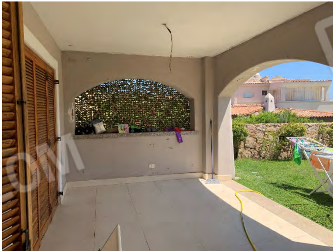
FOTO VERANDA PIANO TERRA
