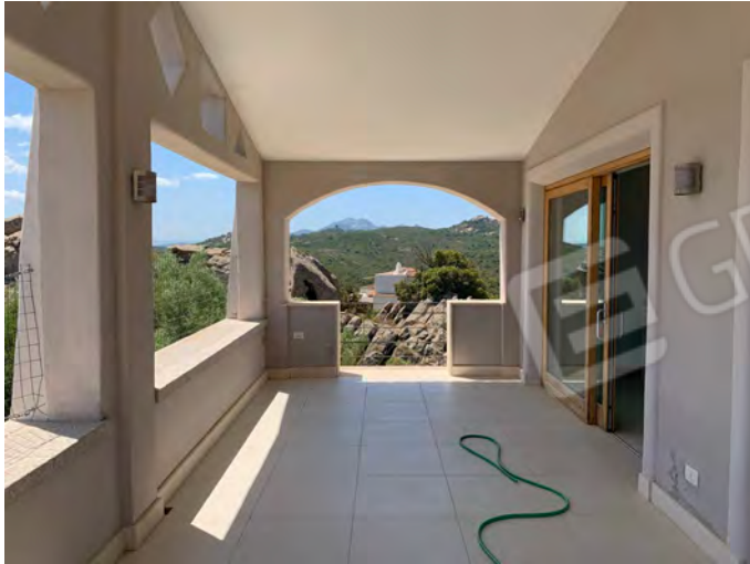
FOTO VERANDA PIANO PRIMO
