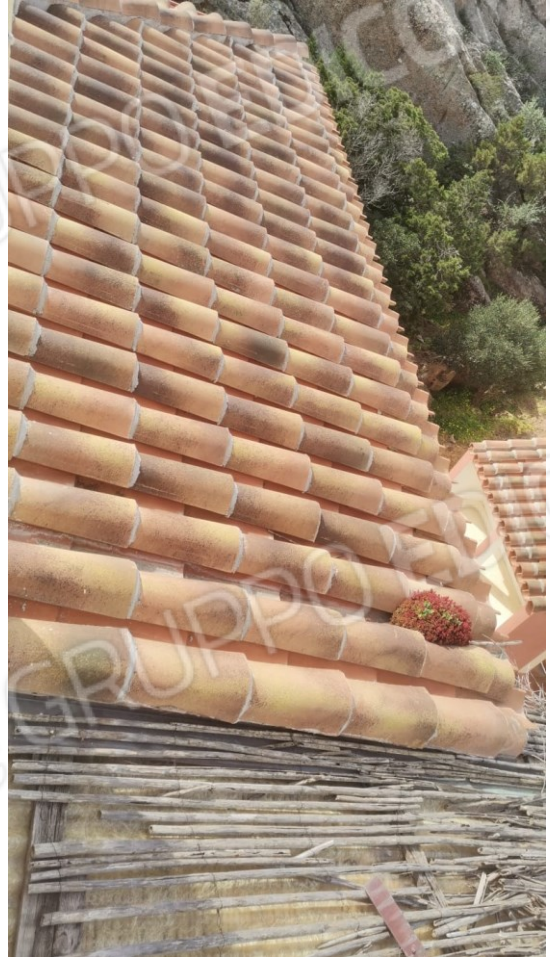
B) STATO ATTUALE DELLA COPERTURA
