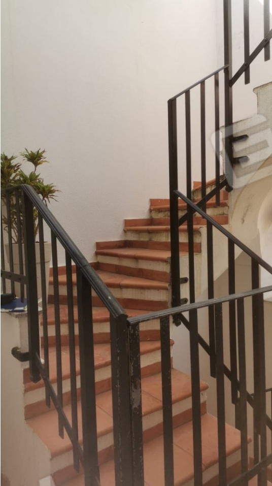
FIGURE 20: A) SCALE DI ACCESSO ALLA COPERTURA;
