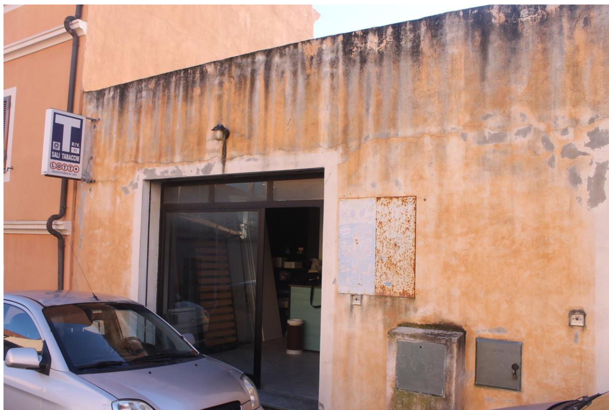
Particolare della facciata esterna dell'immobile
