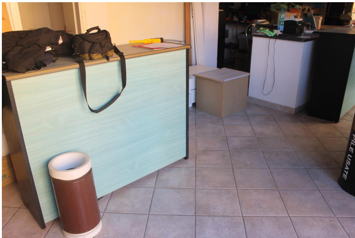
Particolare dei pavimenti del locale
