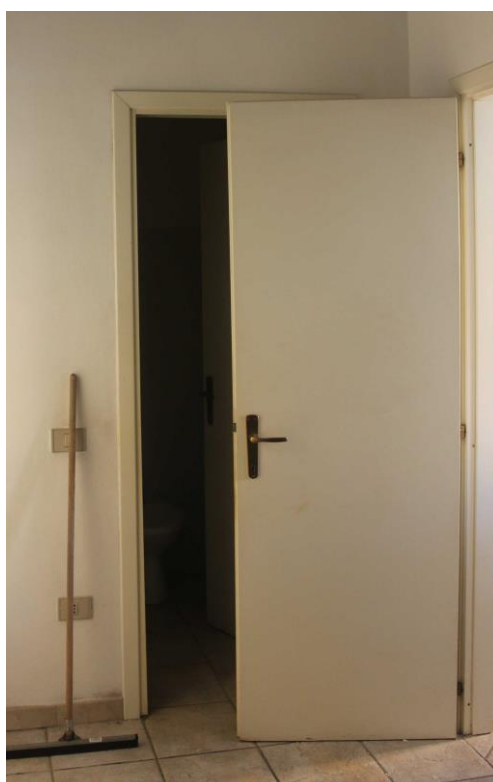
Particolare degli infissi interni in legno
