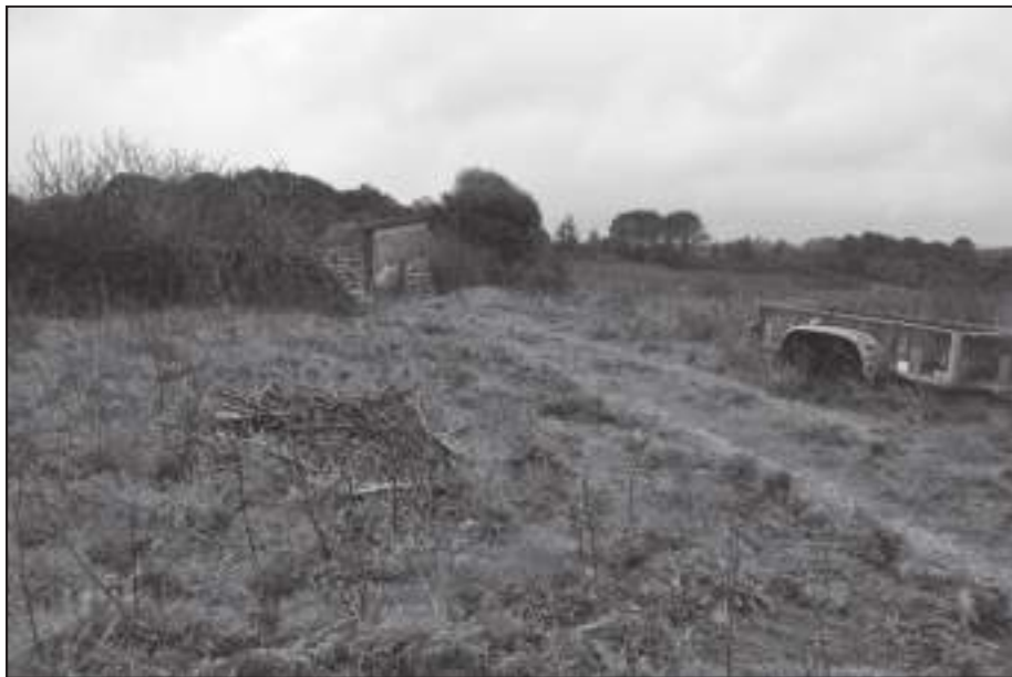
Figg. 24-25. Vista del fabbricato ubicato a monte rispetto all'ingresso al lotto
