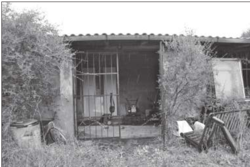
Fig.38. Ingresso del vano doppio
