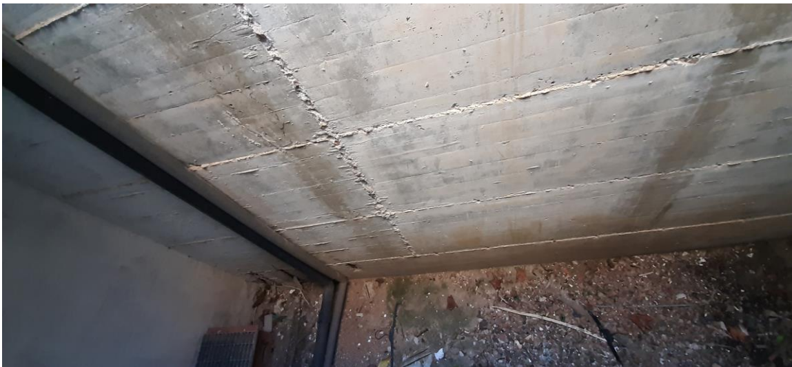
VUOTO SANITARIO PER BOCCA DI LUPO AREAZIONE LOCALE SEMINTERRATO
