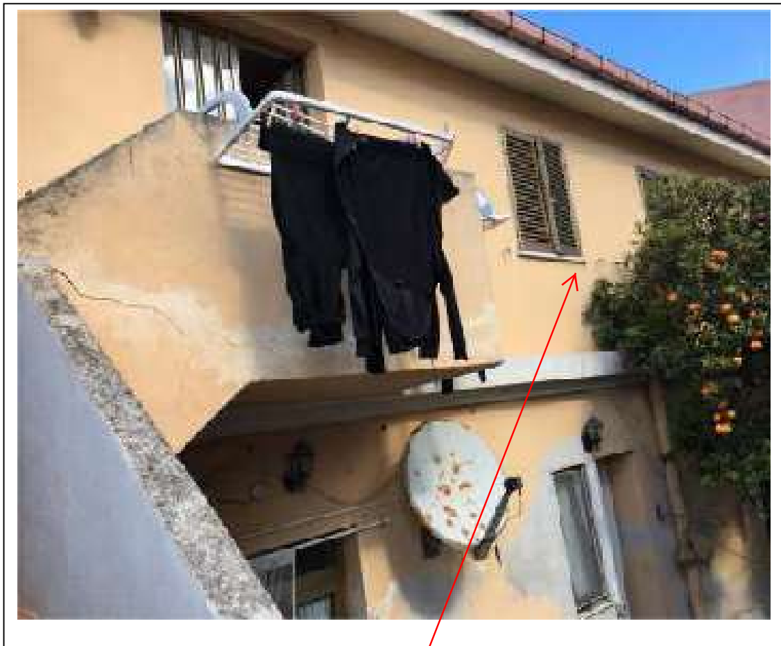
Foto 1 - Prospetto su corte interna
