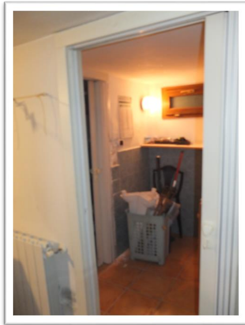
Disimpegno/Ripostiglio piano interrato
