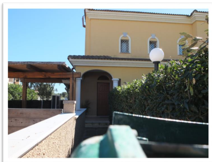
Vista dell'ingresso al piano terra
