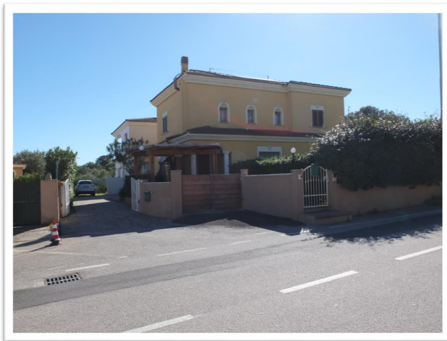
Vista dello stabile dall'esterno su via Montale
