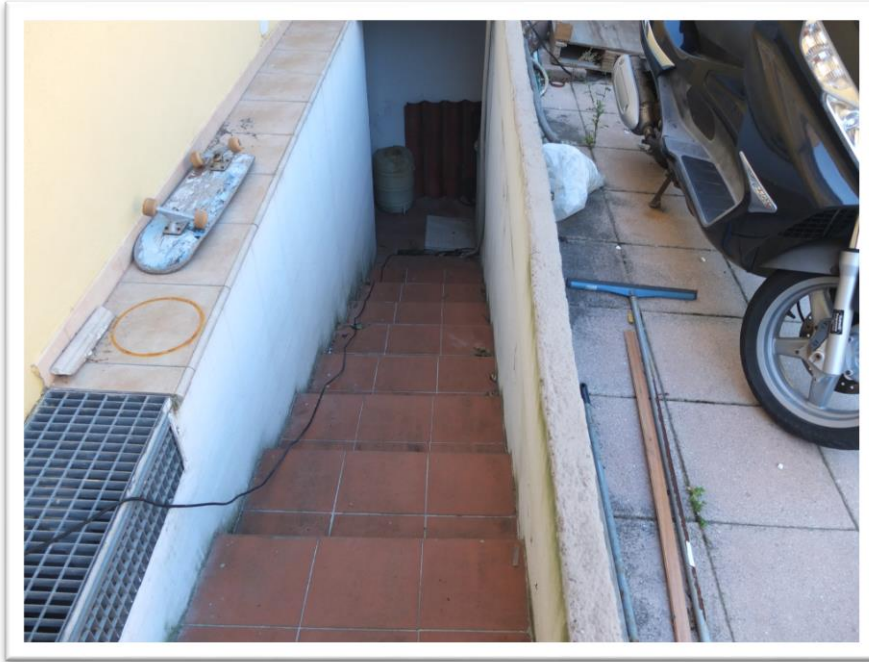
Scala esterna accesso piano interrato
