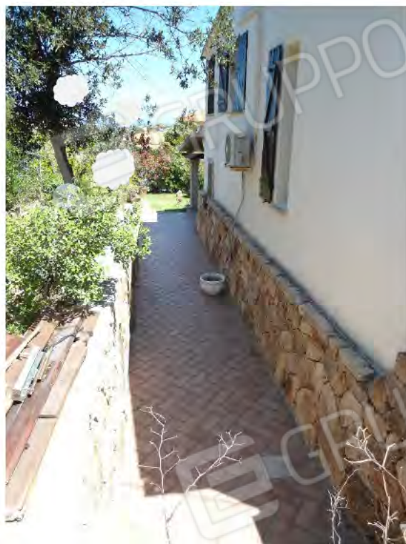
Foto n.9 – Scorcio del fronte S-E
