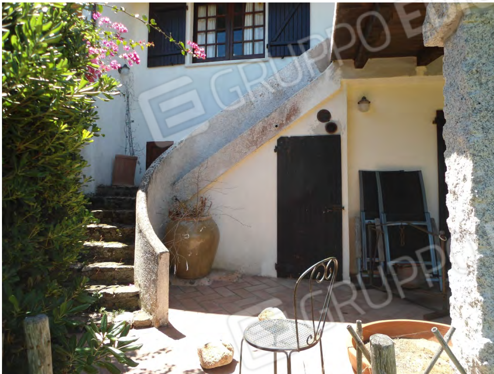
Foto n.3 – Scala di accesso al piano Primo d'ingresso
