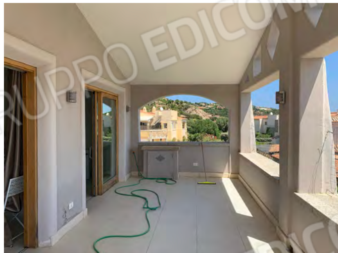
FOTO VERANDA PIANO PRIMO
