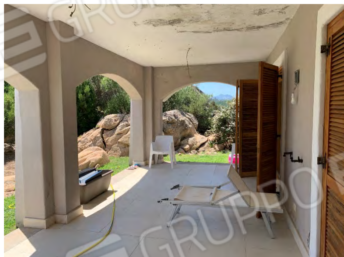
FOTO VERANDA PIANO TERRA
