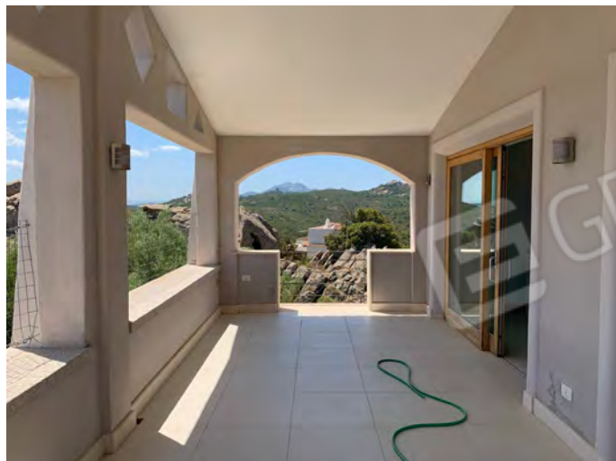
FOTO VERANDA PIANO PRIMO
