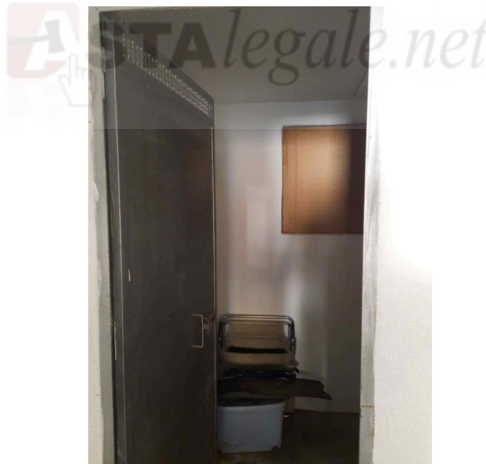
Locale di sgombero
