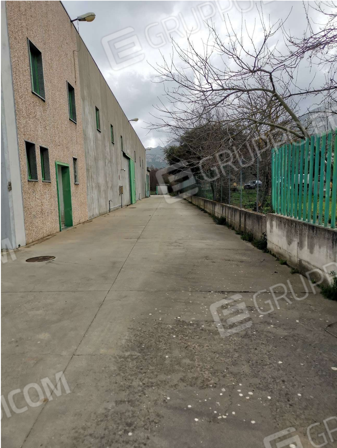
FOTO 007 – DETTAGLIO AREA CIRCOSTANTE AL CAPANNONE
