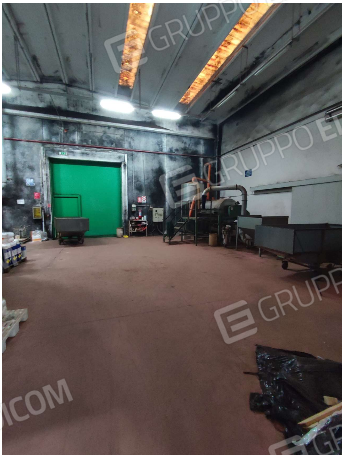
FOTO 023 – PIANO TERRA, LAVAGGIO TURACCIOLI
