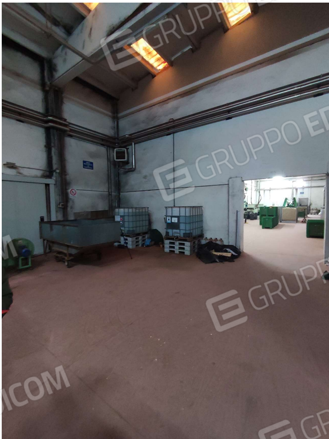
FOTO 024 – PIANO TERRA, LAVAGGIO TURACCIOLI
