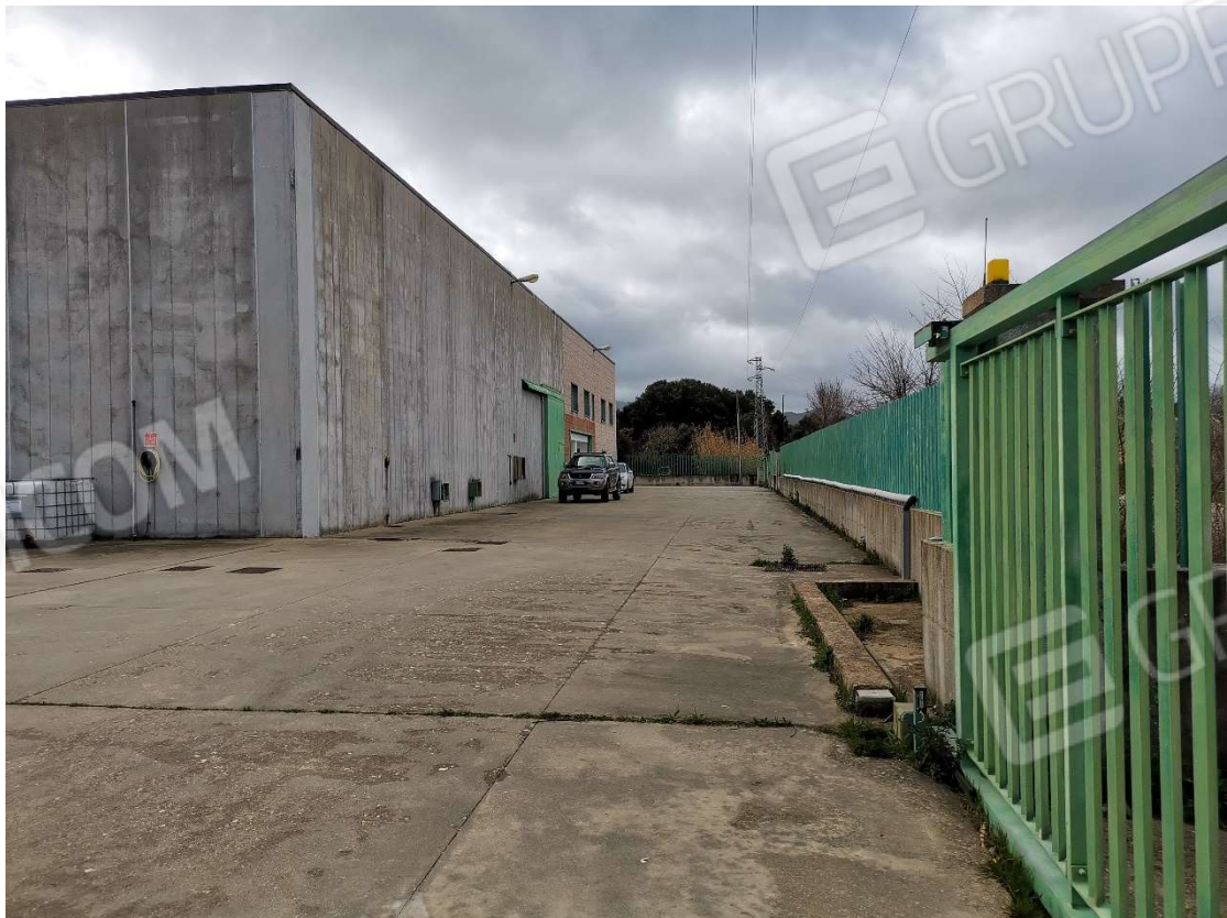
FOTO 002 – DETTAGLIO AREA CIRCOSTANTE AL CAPANNONE
