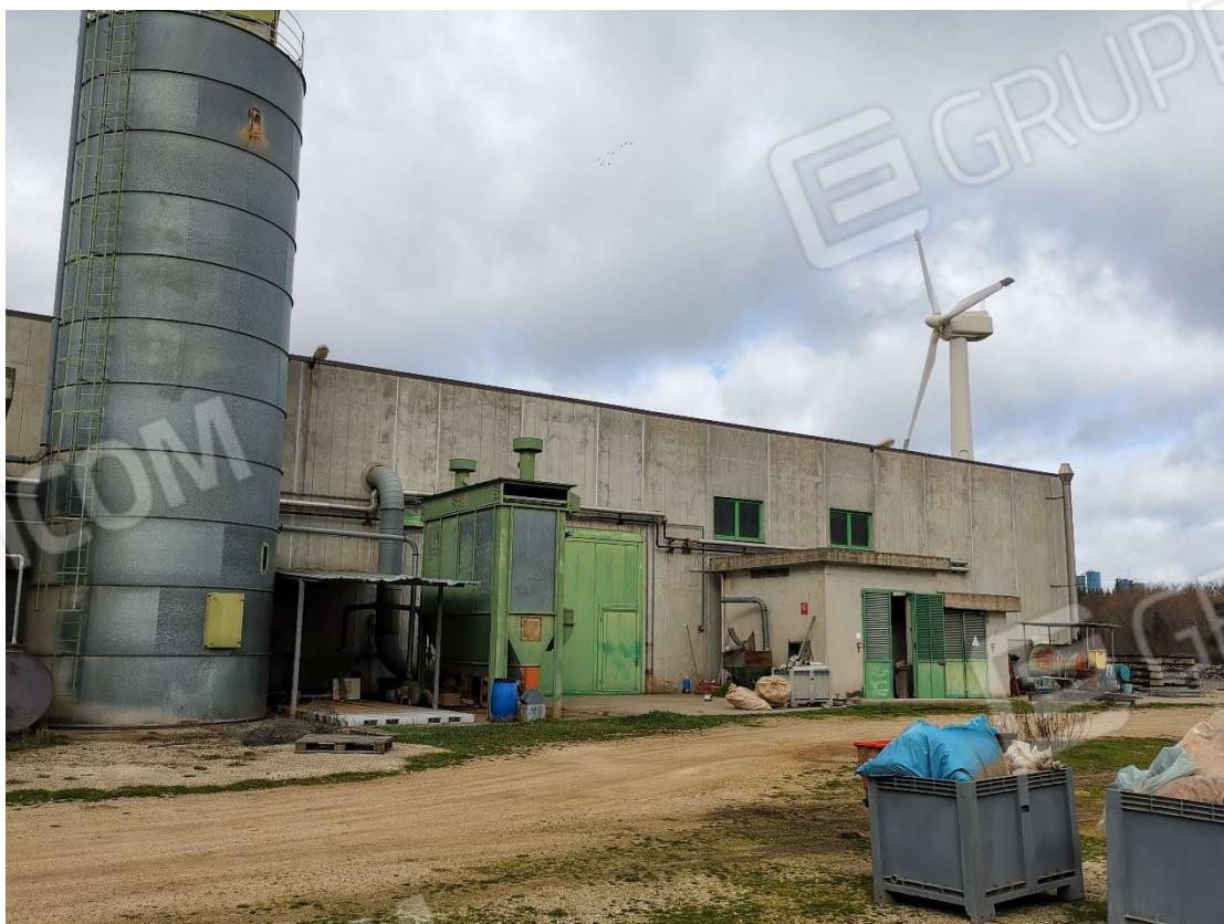
FOTO 004 – DETTAGLIO AREA CIRCOSTANTE AL CAPANNONE
