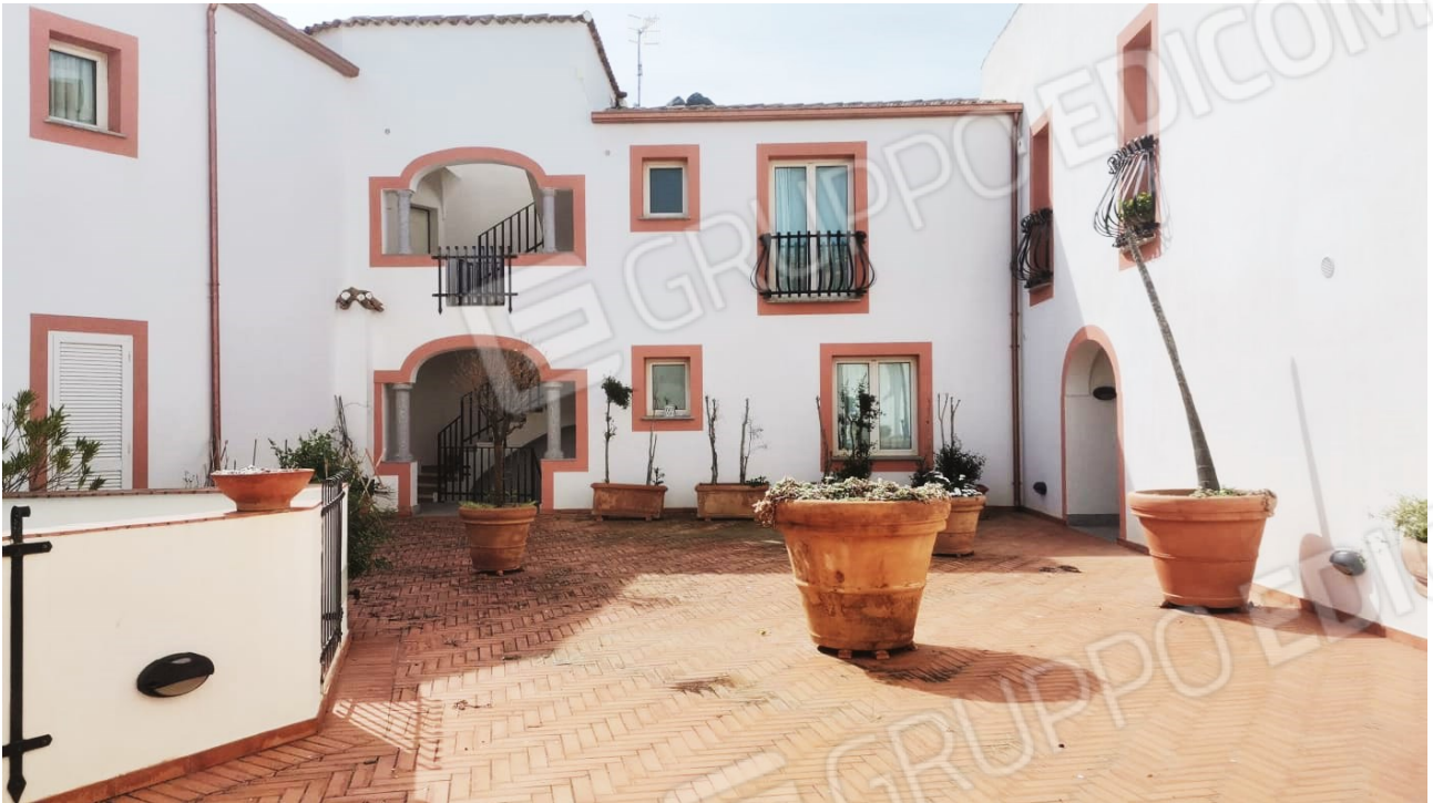
FIGURE 5: FACCIATE INTERNE ALLA CORTA DEL BLOCCO. IN ALTO A DESTRA L'AFFACCIO DALLA ZONA GIORNO (ANGOLO COTTURA) DELL'IMMOBILE OGGETTO DI CAUSA
