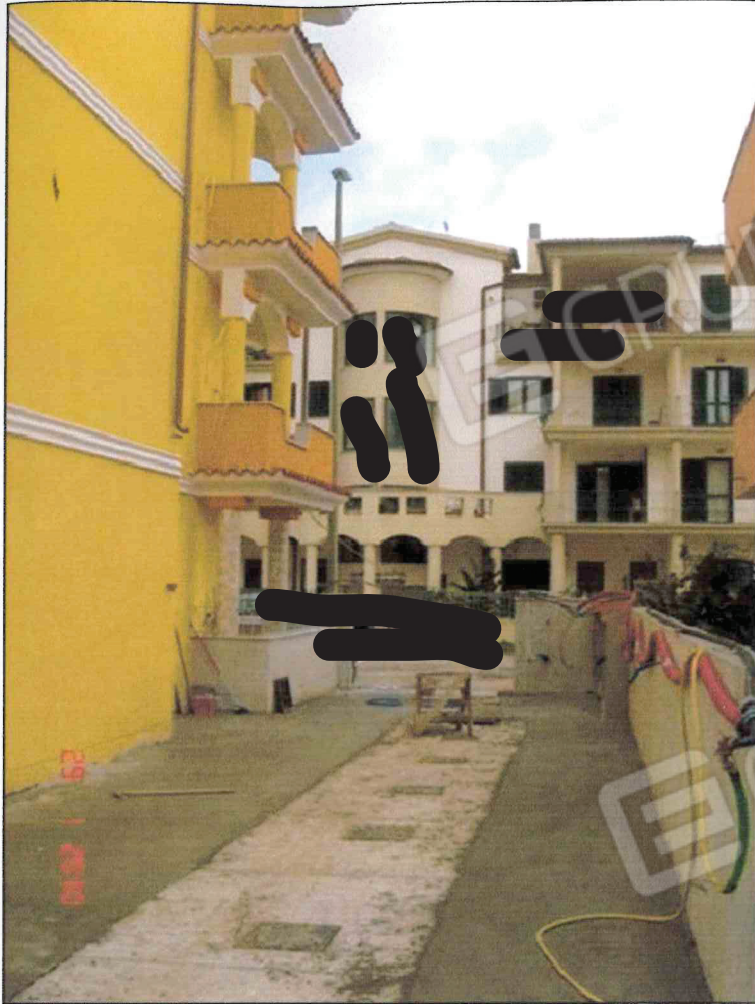
FOTO 7: particolare zona parcheggi e uscita Via Ferrara.
