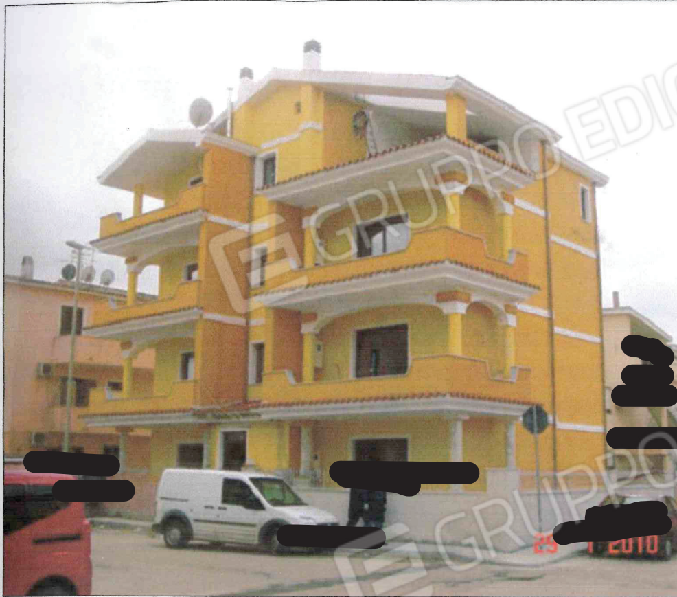
FOTO 1: prospetto principale, Via Ferrara angolo Via Teramo.
