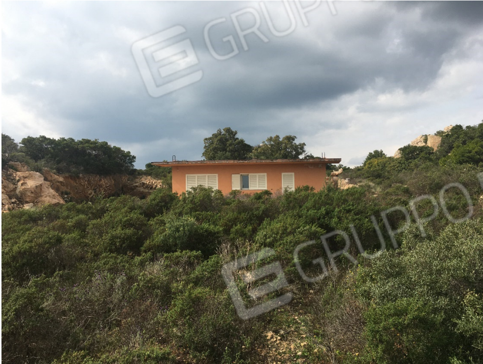
FOTO N° 1 - VISTA PROSPETTO PRINCIPALE - IMMOBILE F.25 PART. 542
