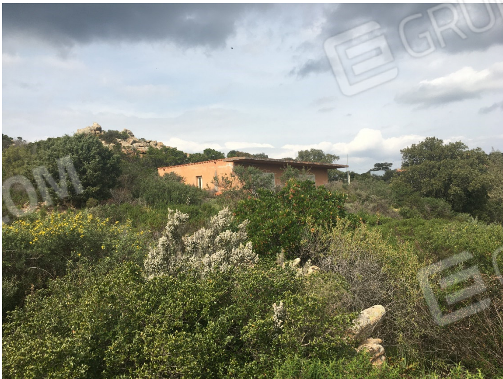
FOTO N° 2 - VISTA PROSPETTO PRINCIPALE - IMMOBILE F.25 PART. 542
