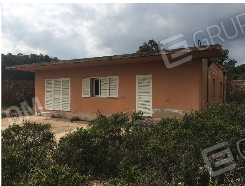
FOTO N° 8 - VISTA PROSPETTO LATERALE - IMMOBILE F.25 PART. 542
