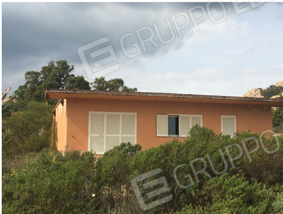
FOTO N° 3 - VISTA PROSPETTO PRINCIPALE - IMMOBILE F.25 PART. 542
