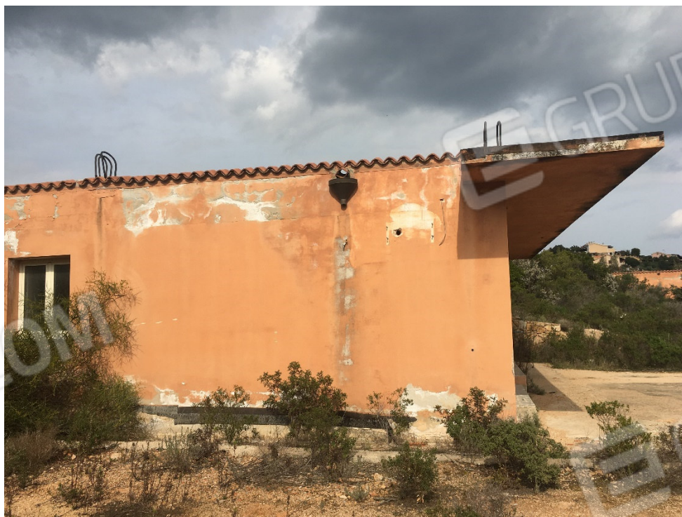
FOTO N° 4 - VISTA PROSPETTO LATERALE - IMMOBILE F.25 PART. 542
