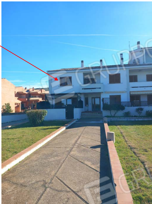
Foto 3 Particolare della vista dell' ingresso principale
