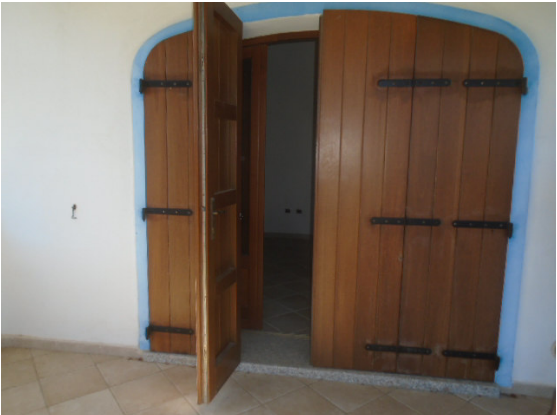
Foto 6 Ingresso Piano terra.
