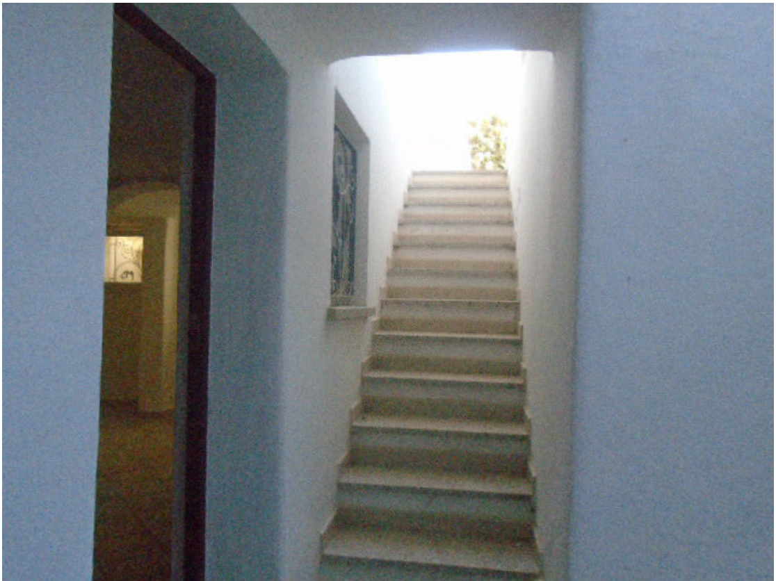
Foto 22 Scale di accesso al piano seminterrato
