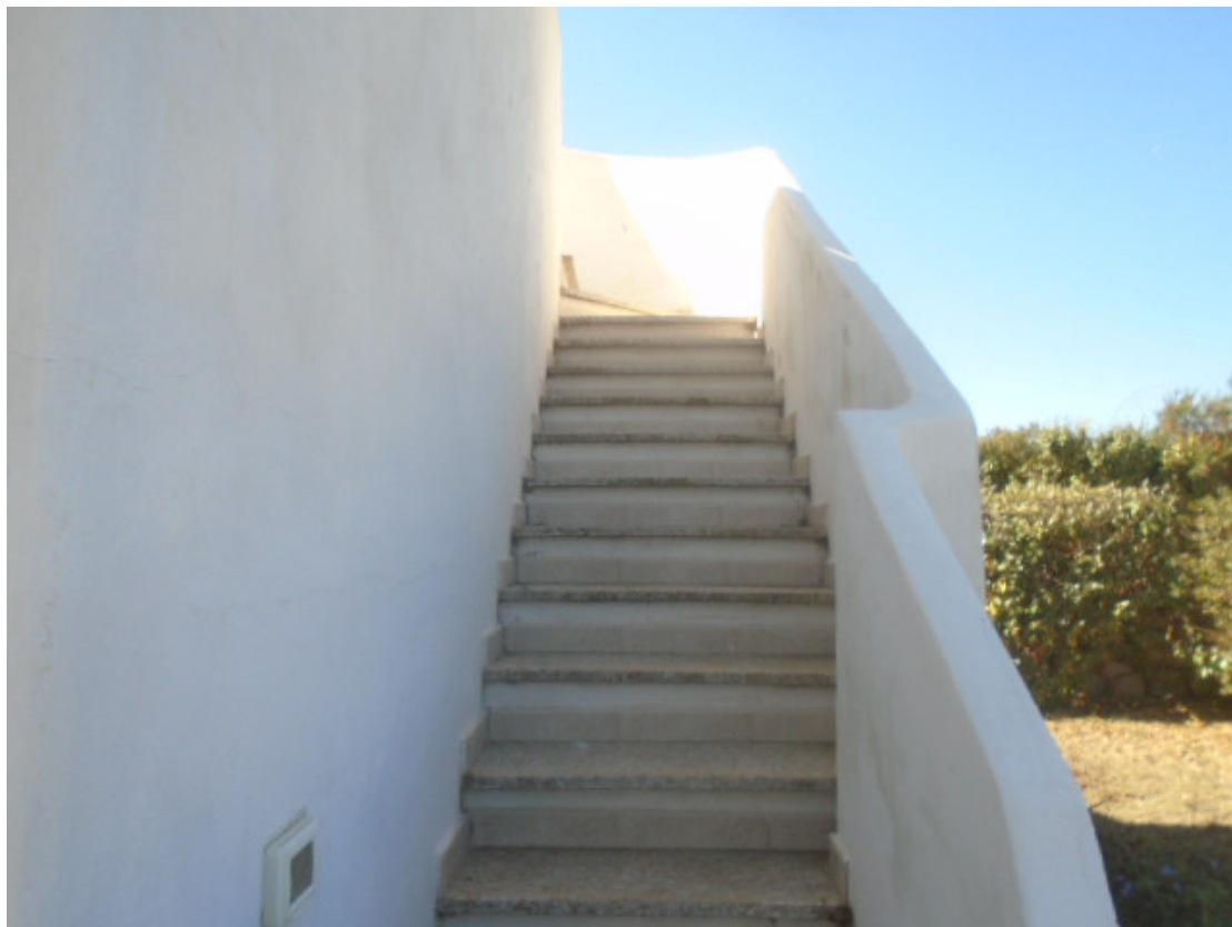
Foto 14 Scale di accesso al terrazzo al primo piano
