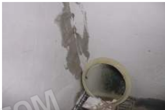
DOCUMENTAZIONE FOTOGRAFICA RIGUARDANTE IL SUB. 19 (INT. C15)
