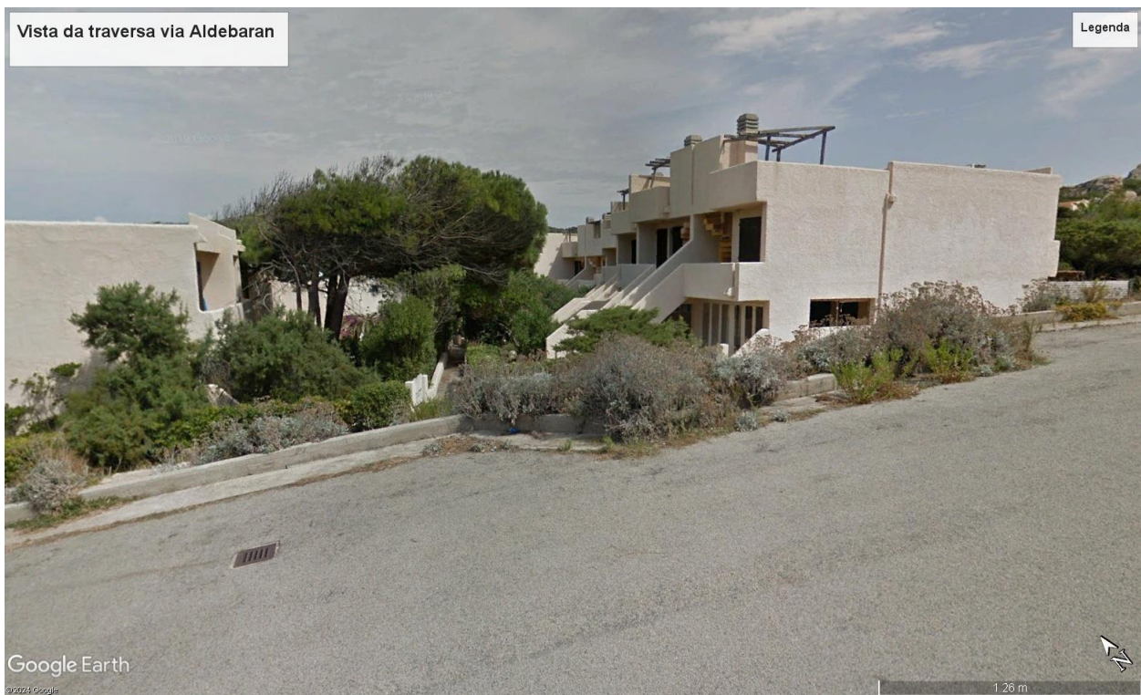
Vista da traversa Via Aldebaran
