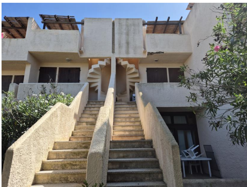
INGRESSO LATO OVEST (appartamento lato destro)
