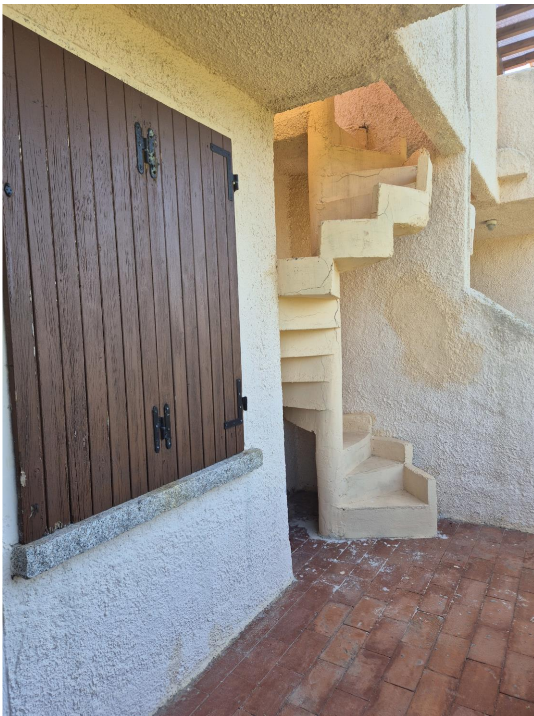
TERRAZZO LATO OVEST CON SCALA
