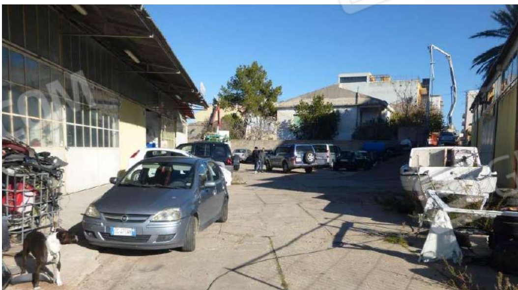
Figura 1 – Viste fronte Nord ed esterno capannoni
