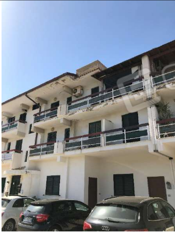
Vista prospetto lato nord
